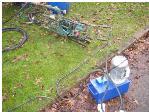
Foto 7. Kopplingar mellan hydraulpump och bentonitpump
