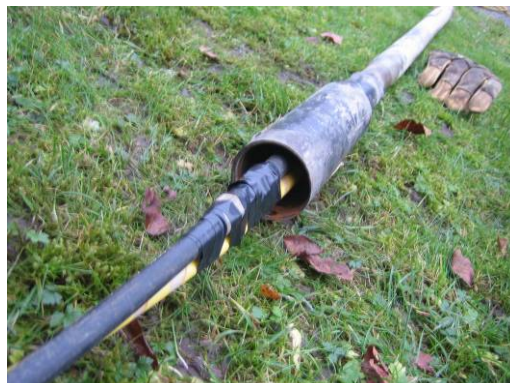
Foto 8. Anslutningen för bentonitslang och MIP-kabel. MIP-sonden i borte delen av bilden och på öppna änden ska sonderingstänger skarvas.
