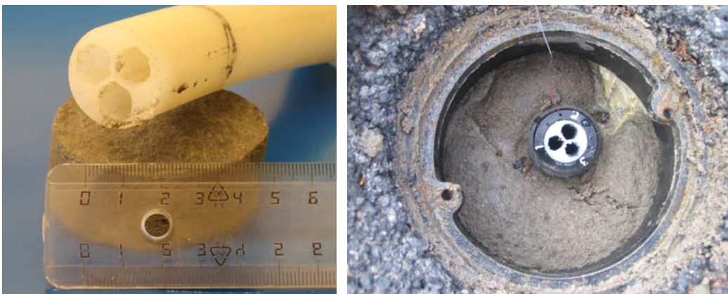
Figur 15 Vänster: En kort bit av CMT-rör som nyttjades i Alingsås. Höger: Installerat CMT-rör på plats i Alingsås.
