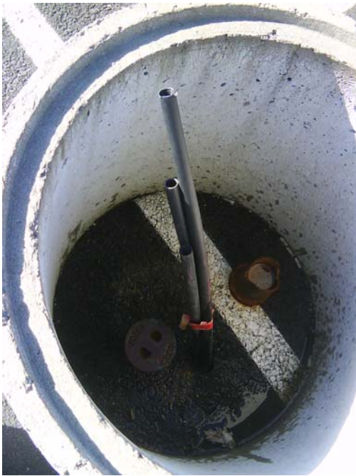
Figur 14 Grundvattnrör 0613 är ett "nested"-rör och består av tre separata, med bentonit inbördes avskärmade, grundvattenrör i ett borrhål.
