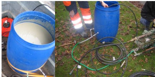
Foto 3. Grön slang går från slurryn till pumpen, svart slang går från pump till munstycke.
