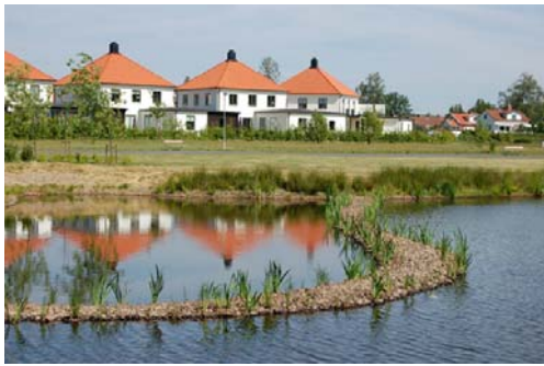
Figur 22 Dagvattendamm i Växjö (Veg Tech AB, 2011)
