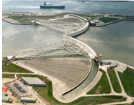
Figur 2 Maeslantbarriären vid Rotterdam (Delta Marine Consultants, 2011)
