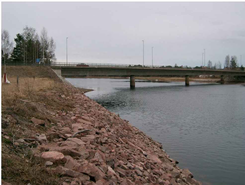
Figur 5-6. Erosionsskydd med strandskoning med sprängsten utmed Österdalälven i Mora. Foto: SGI
