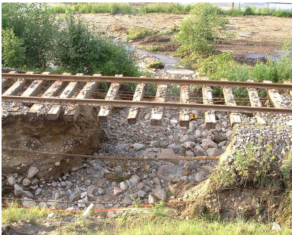
Figur 6-4. Underminering av järnväg vid Väja, Kramfors. Foto: SGI.
