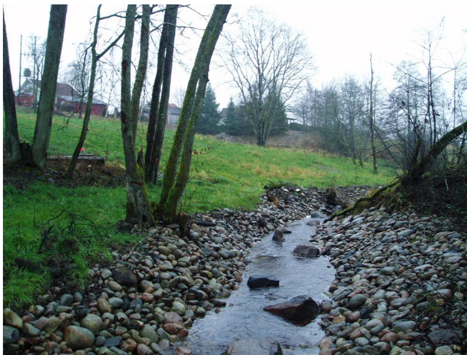
Figur 5-12. Hus på släntrön med erosionskyddad bäck i släntfoten. Foto SGI
