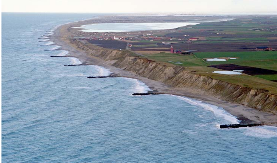
Figur 8-6. Hövder för stabilisering av en kuststräcka. Foto: Kystdirektoratet, Danmark
