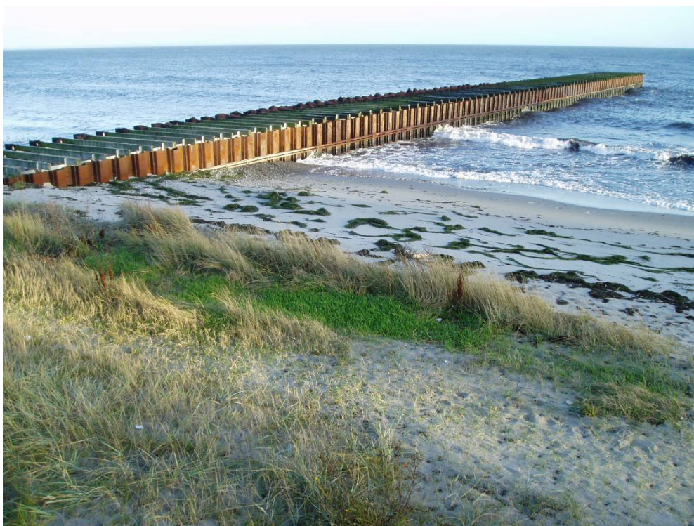
Figur 5-5. Hövder som skydd mot stranderosion vid Ystad Saltsjöbad. Foto: SGI.
