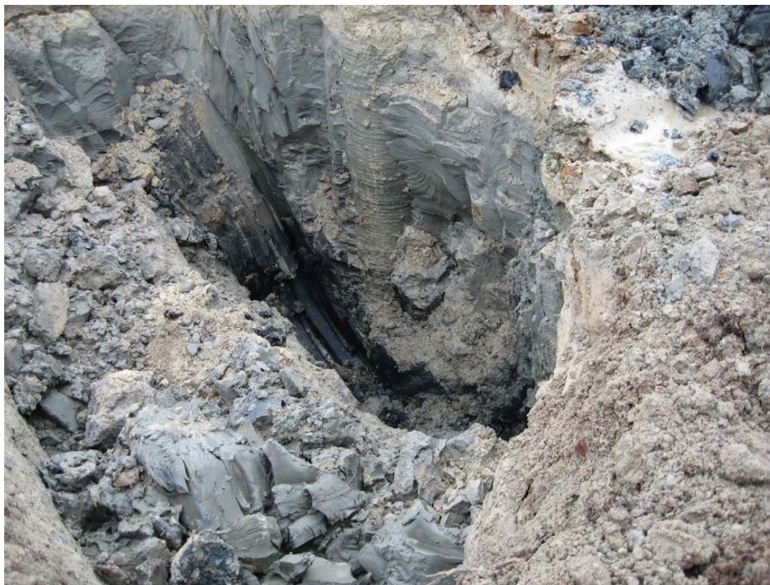
Figur 4-10. Pelare E9 nedschaktad fram till djup 2 – 3 m, pelarstrukturen syns tydligt.
