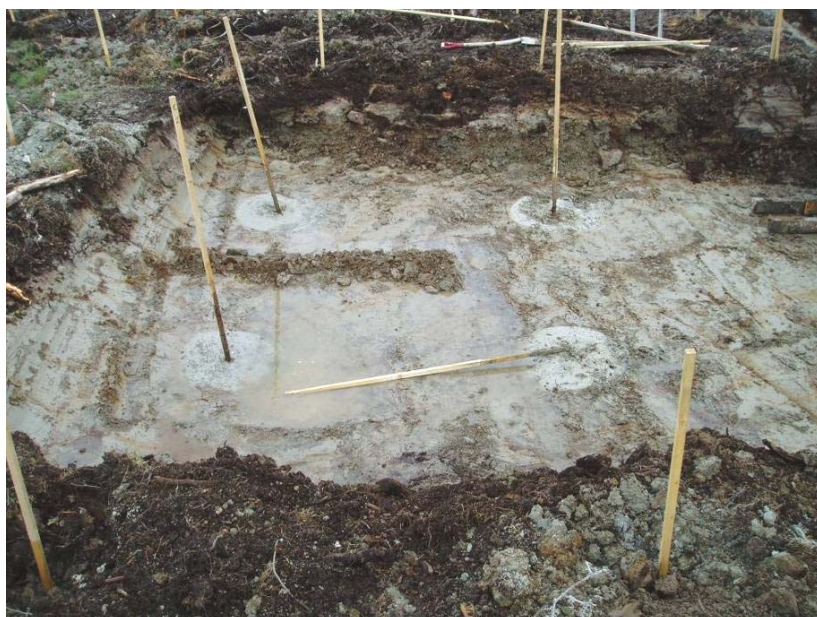
Figur 4-7. Överytan på installerade pelare. Före kontrollsonderingen schaktades pelarna fram, ca 0,5 m jord togs bort.
