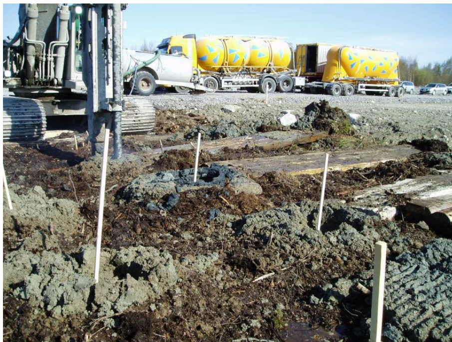
Figur 4-4. Installerade pelare.
