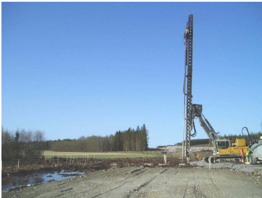
Figur 4-3. Installation av pelare med Hercules KC-maskin.
