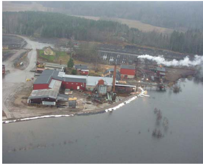
Figur 5-2. Översvämningarna i Arvika år 2000. Invallning av och utpumpning av vatten för att förhindra att vatten stiger in på sågverksområdet. (Foto: Åke Johansson, SGI).
