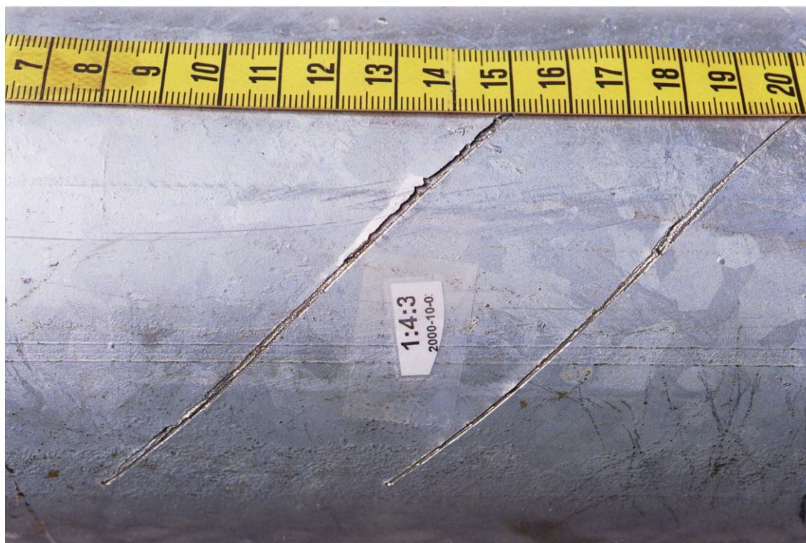
Figur 4.4-5. Detalj av varmförzinkad påle före påslagningen ca 5,6 m från pålspetsen. Provpplats: Universitetsområdet, Påle 4.
