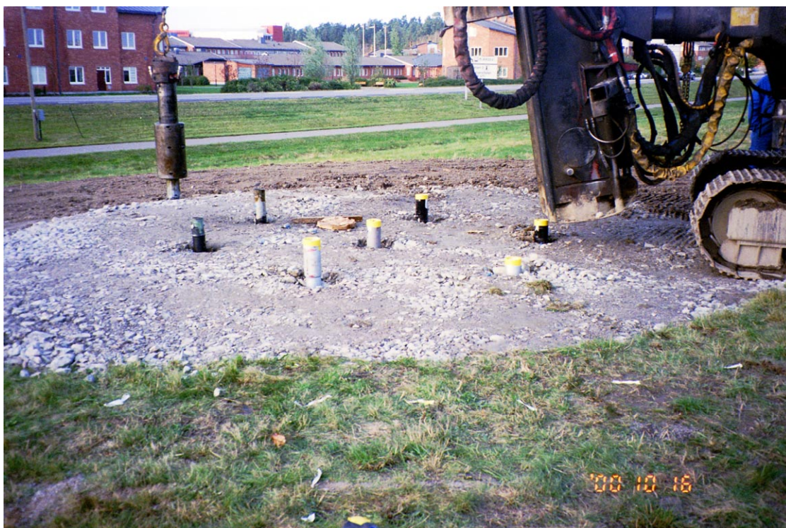
Figur 3.4-2 Provpålar på Universitetsområdet slogs med Banutmaskin till höger och Atlas Copco TEX-vibrationshejare uppe till vänster.
