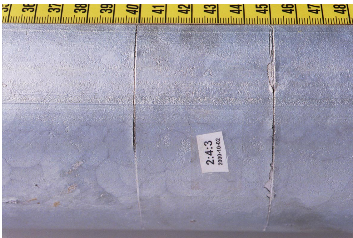
Figur 4.1-5 Varmförzinkad påle: Exempel på att varmförzinkningen lossnar vid de preparerade reporna ca 5,4 m från pålspetsen, Påle 4, Kolbytteomon.
