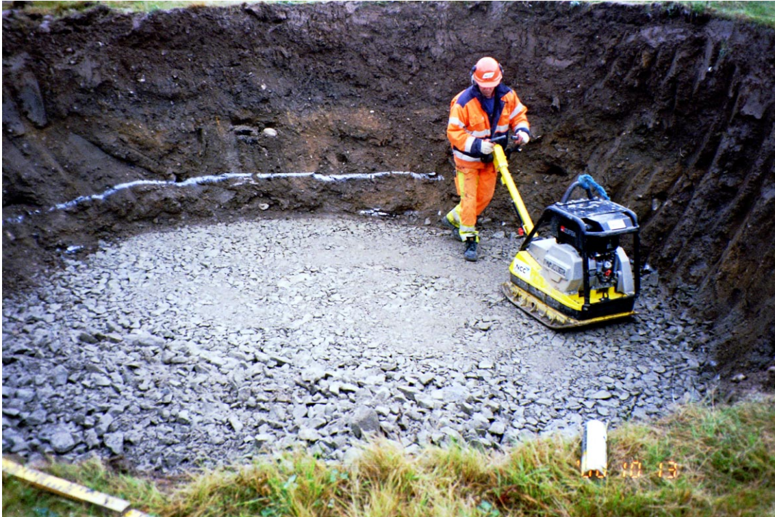
Figur 3.2-3 Packning av fyllningsmaterial – bergkross 0-90 mm – Universitetsområdet.
