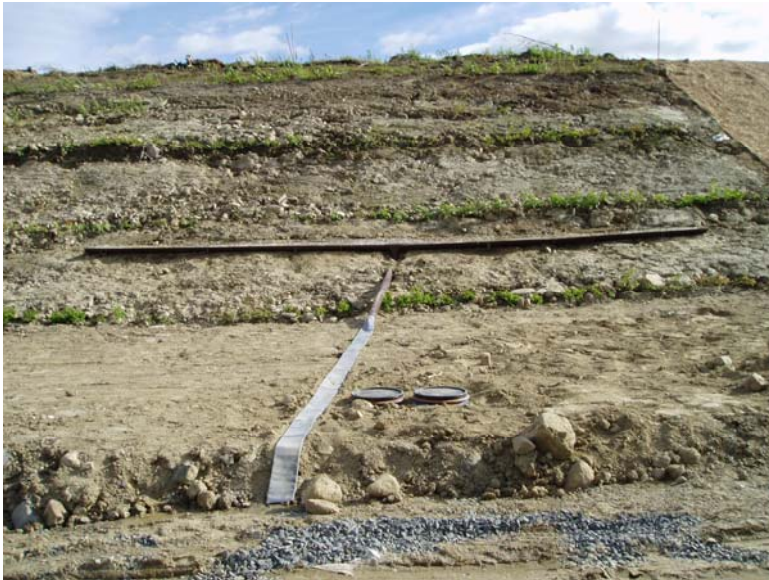
Figur 43. Ytavrinningssystem i yta A, bestående av en 10 m lång stupränna med ett stuprör på mitten som leder vattnet till nergrävda tunnor.
