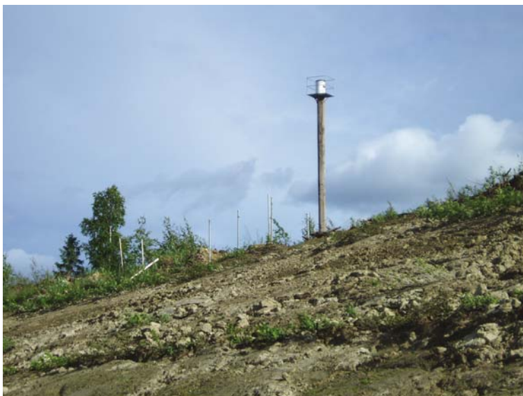
Figur 36. Nederbördsrör i Bispgården. Till vänster i bilden syns portrycksrören.
