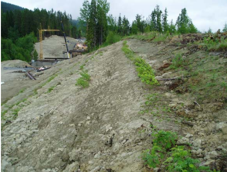
Figur 16. En nedåtriktad förskjutning av de extra häcklagren närmast bro 3 (längst bort i bilden).
