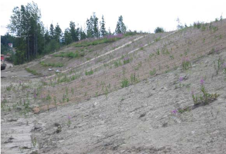
Figur 17. Häck-grenlager nummer 1 hamnade i släntfot efter det att ett diket fyllts igen.
