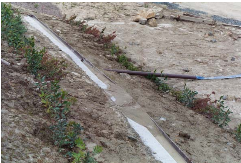
Figur 29. Erosion under terrass 3 som flutit ner i avrinningsrännan.
