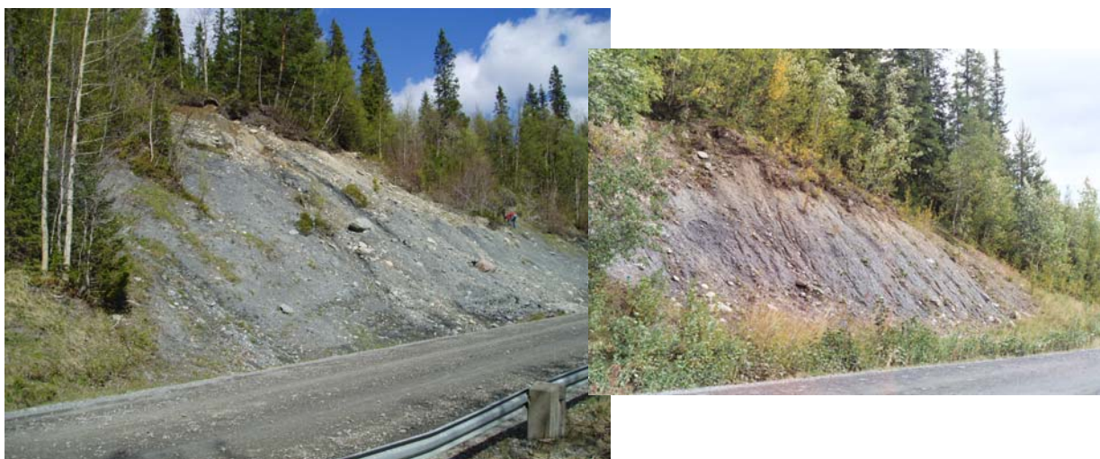
Figur 46. Erosion i skärningslänter längs väg 630 runt Bydalen.
