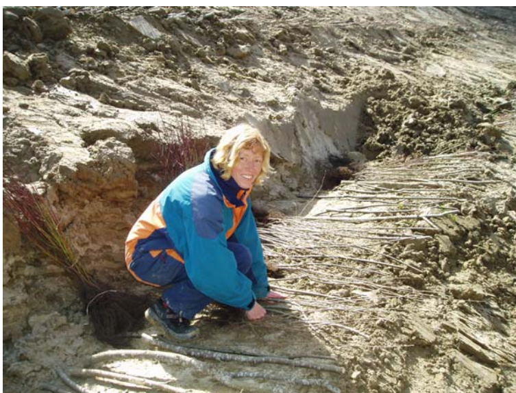
Figur 9. Placering av sticklingar och rotade plantor i häck- och grenlagren.
