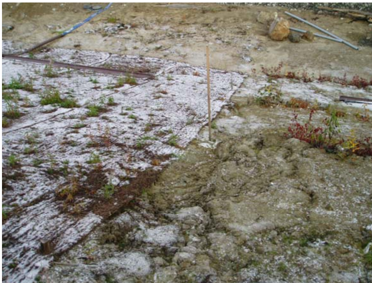
Figur 34. Erosion mellan yta A och B.
