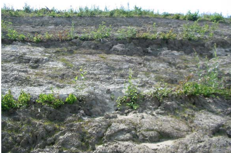
Figur 19. Glesare partier i häck-grenlager 2,3 och 4 i områdets centrala del där salixgrenarna inte hade överlevt etableringen. (Foto Strand-Hübinett)
