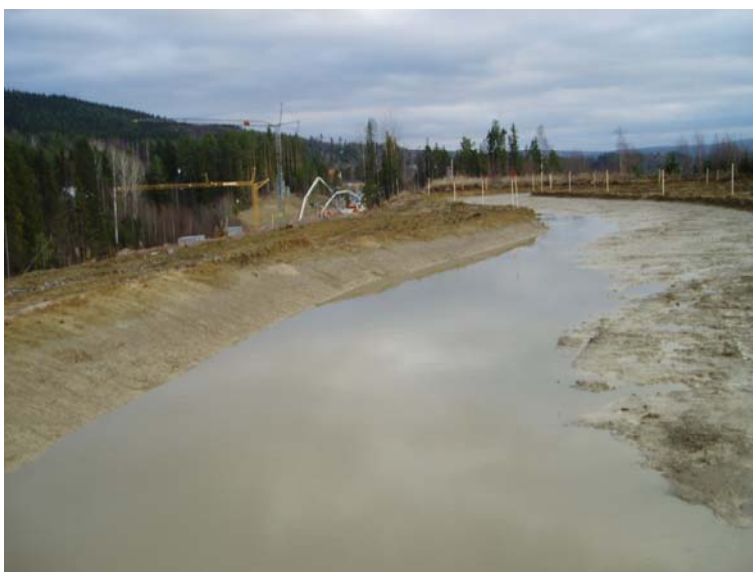
Figur 41. Stående vatten på markytan efter avschaktning ovan släntkrön. Foto taget i november 2004.
