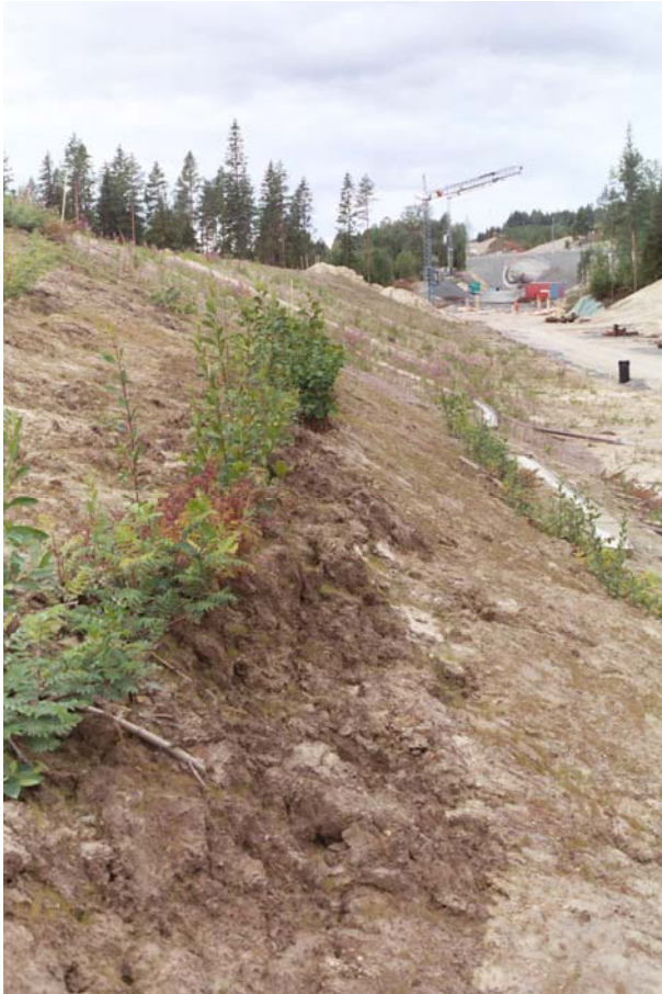
Figur 28. Förskjutning av slänten vid häck-grenlager 3. Foto taget 2004-09-06.
