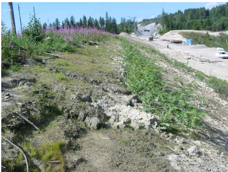
Figur 22. Skillnad i markfuktighet mellan växtetablerad och icke växtetablerad (närmast kameran) yta. (foto Strand-Hübinett)
