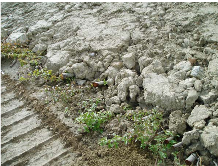
Figur 15. Skottsatta salixgrenar och grönskande plantor.
