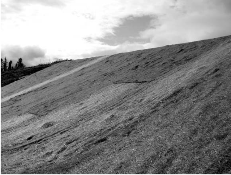
Figur 11. Erosionsskydd för yta B, avbaningsmassor täckta med halmmatta.
