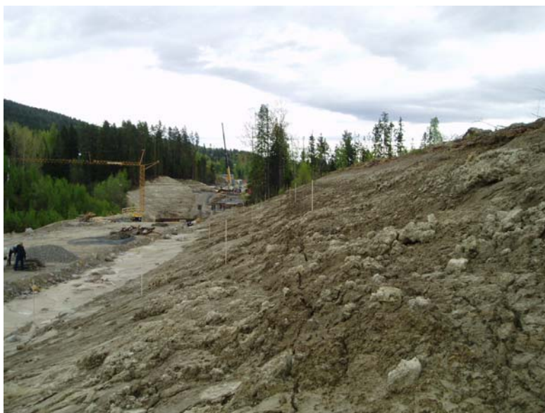
Figur 2. Starkt flytbenägen och tjälskjutande siltjord i Bispgården. Foto taget 17 maj 2004 i riktning mot bro 3.
