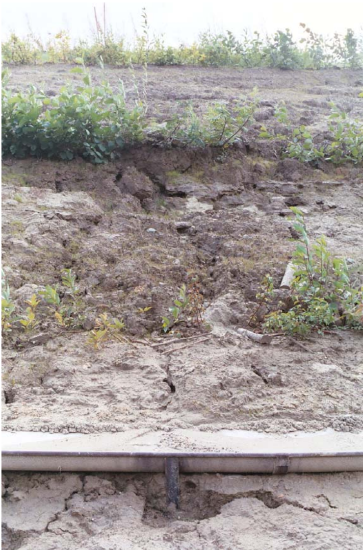
Figur 30. Erosion mellan terrass 2 och 3.
