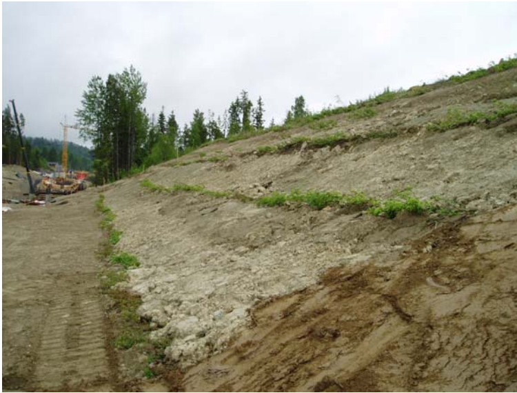
Figur 14. Gröna häck-grenlager i slänt C, Bispgården, drygt en månad efter etablering.
