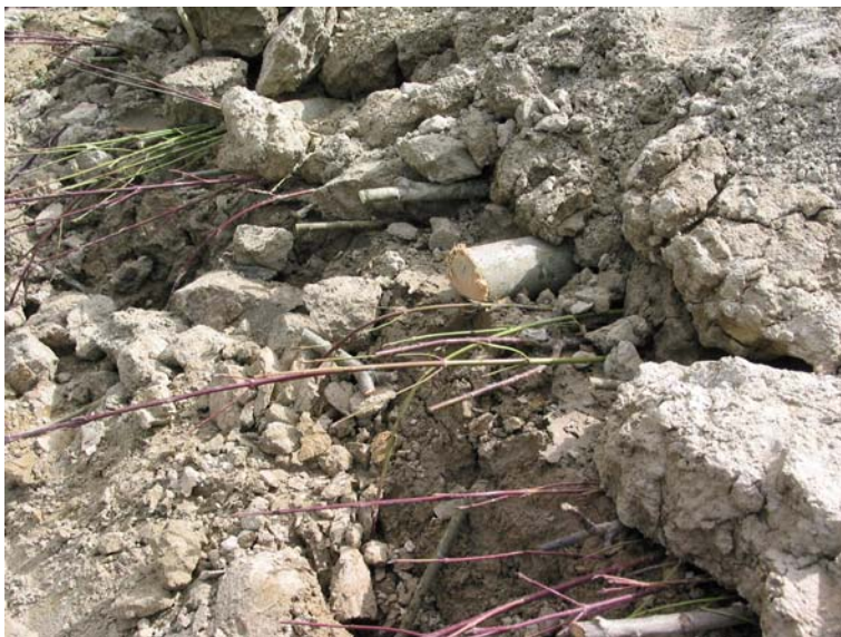
Figur 10. Färdigt häck-grenlager.
