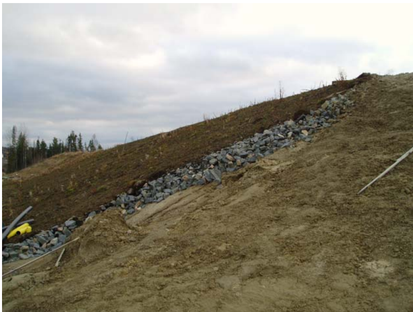
Figur 13. Erosionsskydd på yta C, samkross och förnaskikt.
