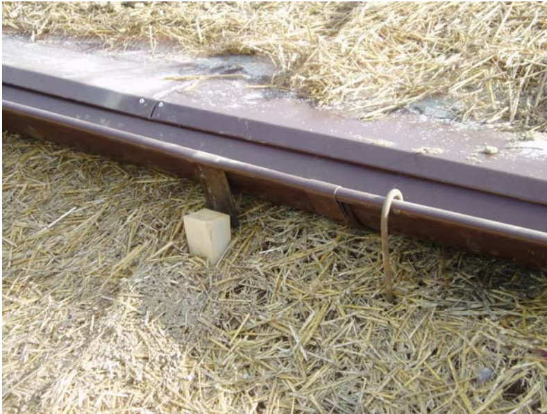
Figur 45. En plåt monterades i rännornas överkant i syfte att förhindra ytvatten från att rinna in under rännorna.
