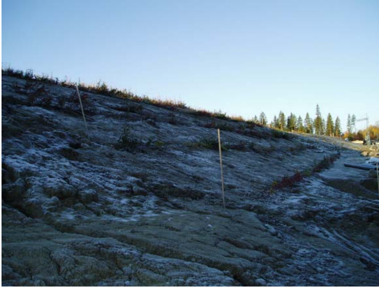
Figur 33. Erosion till vänster om yta A, mot bro 3.
