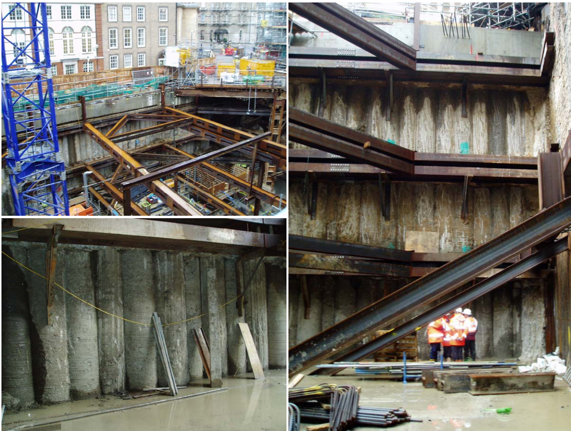
b. Sekantpålevägg efter urschaktning för källare.
