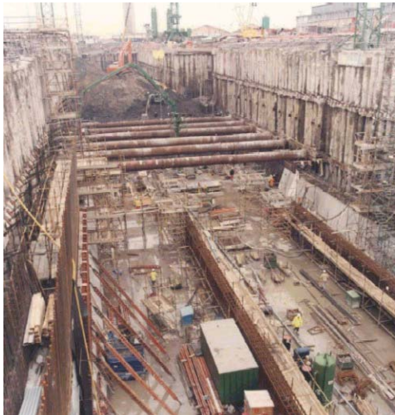
Figur 13. Schaktning för North Greenwich Station i London. Från Bachy (2003).
