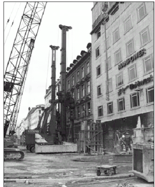
b) Utförande av sekantpålning intill en grannbyggnad.
