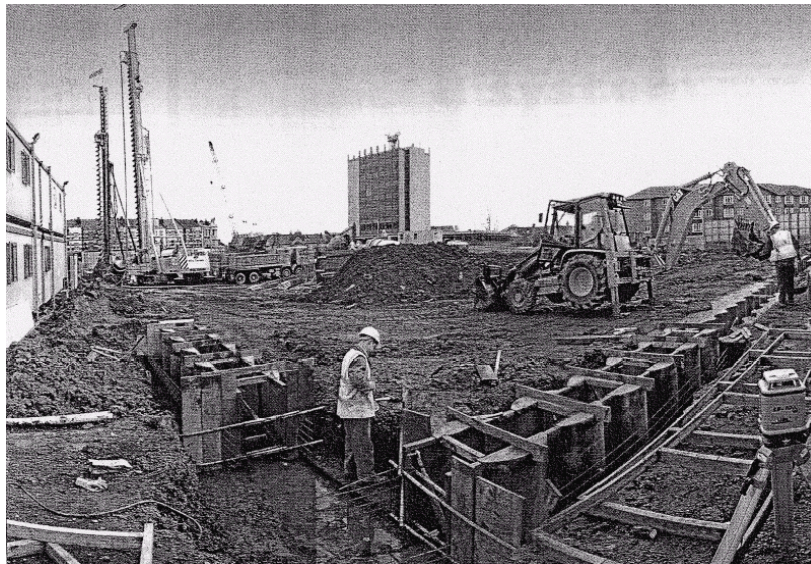
Figur 9. Sekantpålning vid Community Arts Center. Tillverkning av styrvägg för primärpålar i förgrunden. Från Ground Engineering (2002a).
