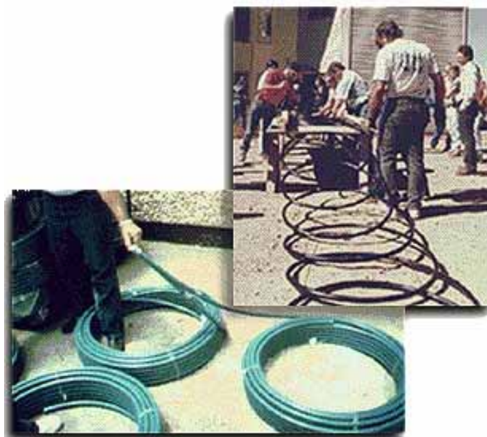
Figur 6.6. Slinky levereras i rullar och arrangeras på plats innan den läggs i diket ( www.alliantgeo.com , 2000).
