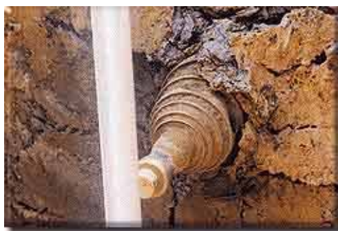
Figur 5.7. Schaktgrop vid mottagningspunkt. Foto ur Vretmaskin ( www.vretmaskin.se , 2000).
