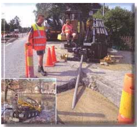
Figur 5.6. Schaktgrop vid startpunkt för drivning av slang med styrd borrhning. Hårdgjord yta har avlägsnats. Foto ur Styrud AB ( www.styrud.se , 2000).
