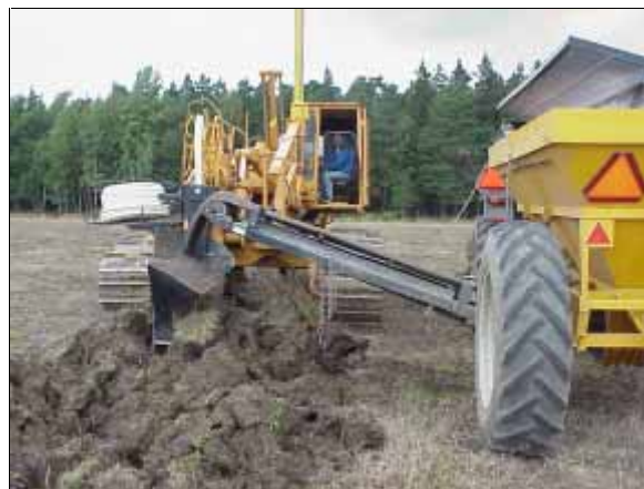
Figur 5.14. Direktläggning av dräneringsledning med statisk plog. Sand för kringfyllnad strilas ned via transportbandet i läggboxen och faller ut runt ledningen. (Foto: Jan Fallsvik, SGI).
