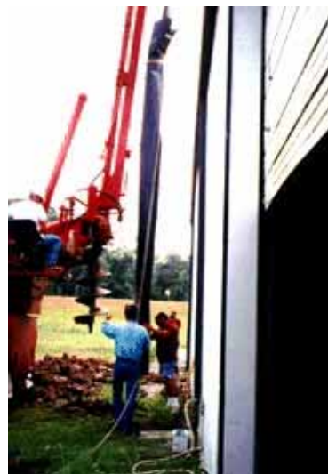
Figur 4.10. Geobag installeras i borrhål. ( www.alliantgeo.com , 2000).
