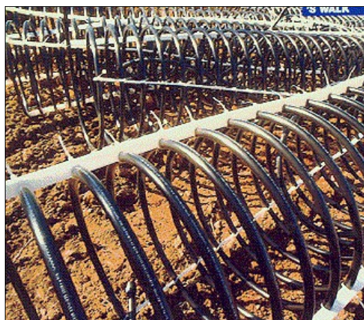
Figur 6.10. Fixering inför installation i borrhål ( www.alliantgeo.com , 2000).
