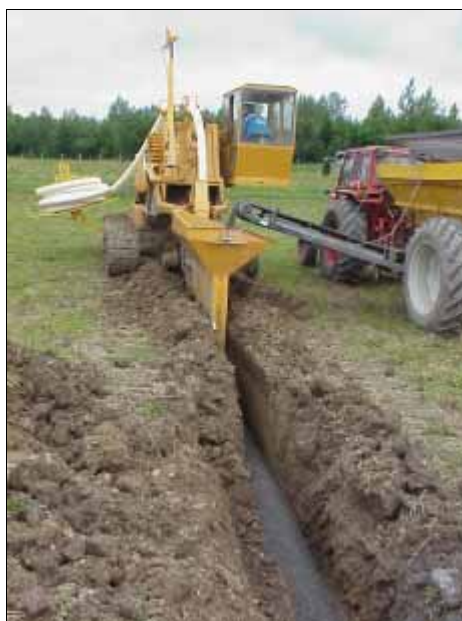
Figur 5.23. Direktläggning med fräs. Sand/dräneringsgrus strilas samtidigt ner och läggs runt ledningen. (Foto: Jan Fallsvik, SGI).
