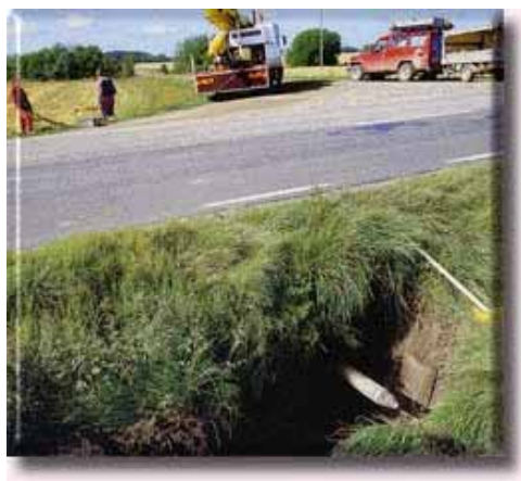
Figur 5.10. Drivning av ledning under väg med jordraketen. Foto från Styrod AB ( www.styrod.se , 2000).
