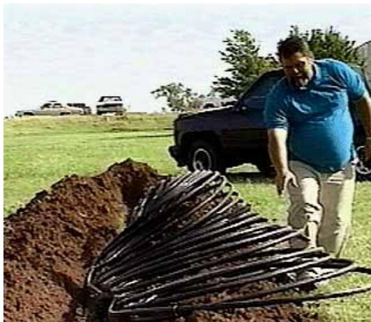
Figur 6.7. Installation av stående Slinky i dike. ( www.alliantgeo.com , 2000).
