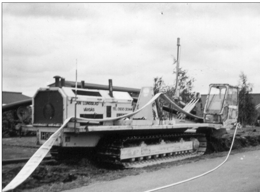
Figur 5.16. Direktläggning av flera slangar på olika djup i samma plogfåra, med 18-tons bandgående statisk plog. (Foto: Jan Fallsvik, SGI).
