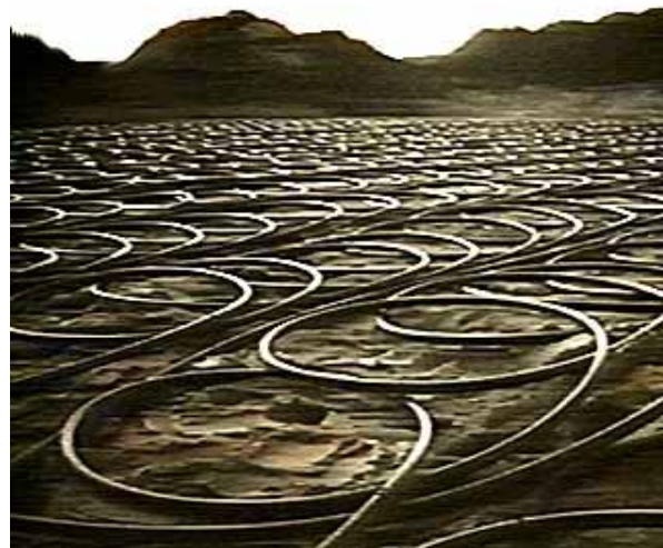
Figur 6.4. Installation av flera liggande Slinky i grund schakt. Avser främst större kommersiella byggnader. ( www.alliantgeo.com , 2000).
