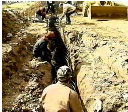
Figur 6.8. Installation av liggande Slinky i dike. ( www.alliantgeo.com , 2000).
