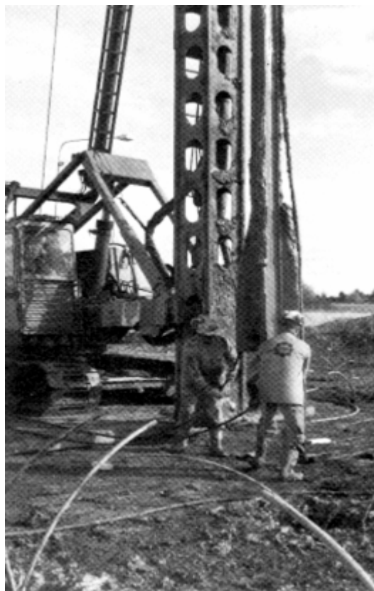
Figur 7.5. Installation av dubbla U-rör för värmelagret i Söderköping (Magnusson et al, 1992).
