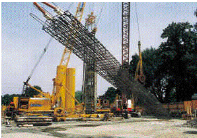
Figur 4.8. Armeringskonstruktion för en slitsmur, med fastmonterade rörledningar för värmeväxling mot omgivande jord (Swiss geothermal programme, 2001, www.geothermal-energy.ch ).
