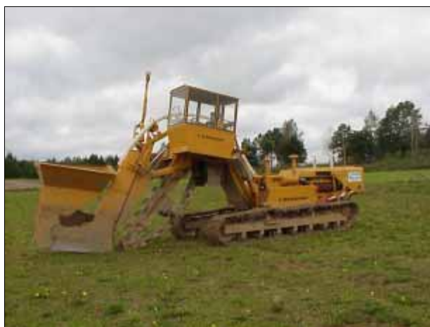
Figur 5.21. Direktläggning med fräs. En läggbox är monterad bakom fräsen. (Foto: Jan Fallsvik, SGI).
