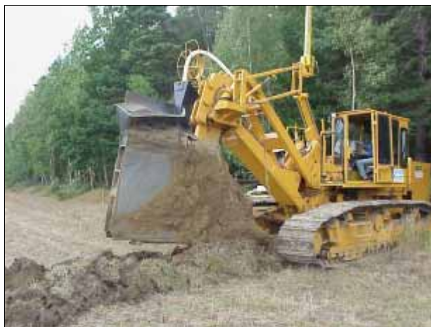
Figur 5.12. Plog för direktläggning av dräneringsrör för täckdikning, 35 tons bandgående statisk plog. Laggerbox i upplyft läge. (Foto: Jan Fallsvik, SGI).
