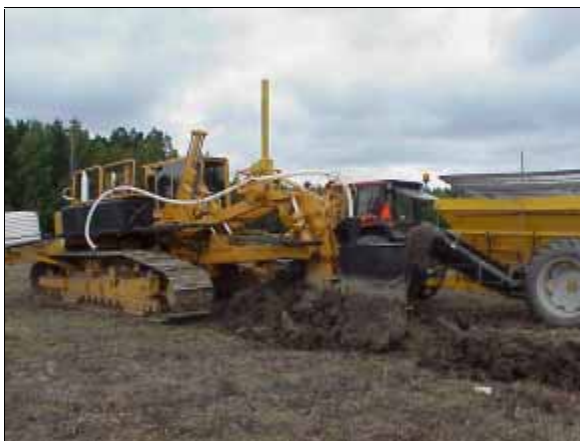
Figur 5.13. Direktläggning av dräneringsledning med bandgående statisk plog. Plogen har en påmonterad slangvinda. Den åtföljs av en traktordragen flakvagn med påmonterad bandtransportör för kringfyllning av skyddssand. (Foto: Jan Fallsvik, SGI).
