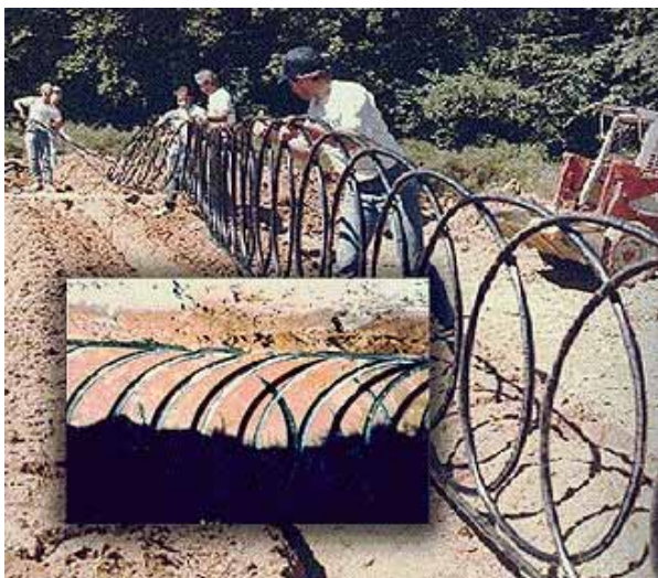
Figur 6.3. Installation stående i diken. ( www.alliantgeo.com , 2000).
