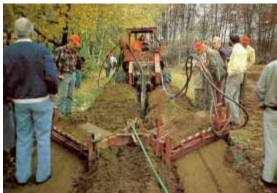
Figur 5.24. En släde med "omvända" schaktblad bogserad efter läggbox på en fräs. Schaktbladen återfyller schaktmassorna i ledningsgraven. (Källa: Göran Helltröm, LTH).
