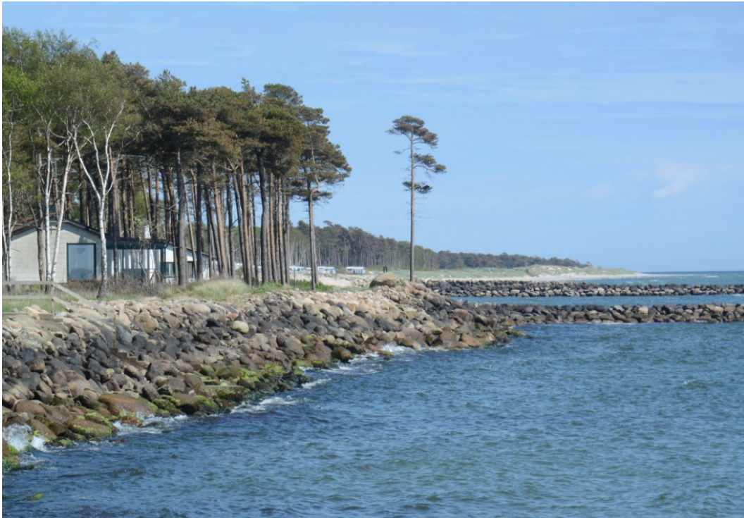
Figur 6.13 Erosionsskydd i form av stenskoning vid Löderups strandbad i Ystad kommun. I fjärran syns campingplatsen och strand med erosionsbranter, men utan erosionsskydd. Foto: A. Björlin, SGI.
