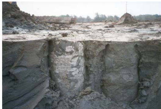
Framschnitt av Kalkcementpelare. (Limecement columns).
