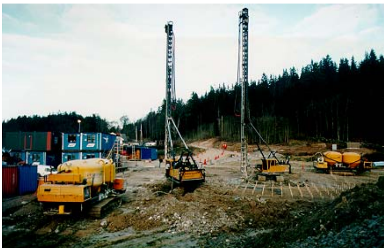
Exempel på utrustning för djupstabilisering med kalkcementpelare i arbete. (Example of equipment for deep mixing with limecementcolumns in operation).
