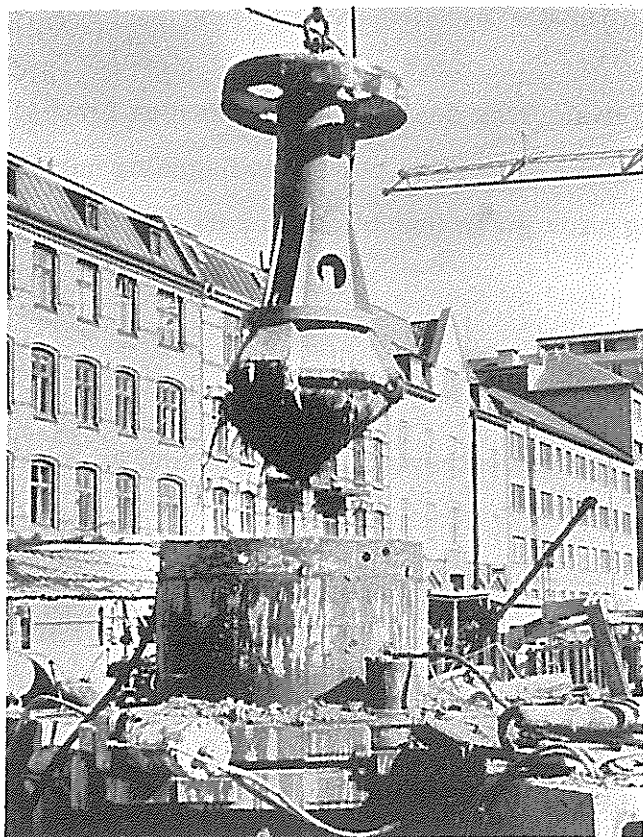
Fig. 4. Vridaggregat och gripskopa vid utförande av GH-pelare.
