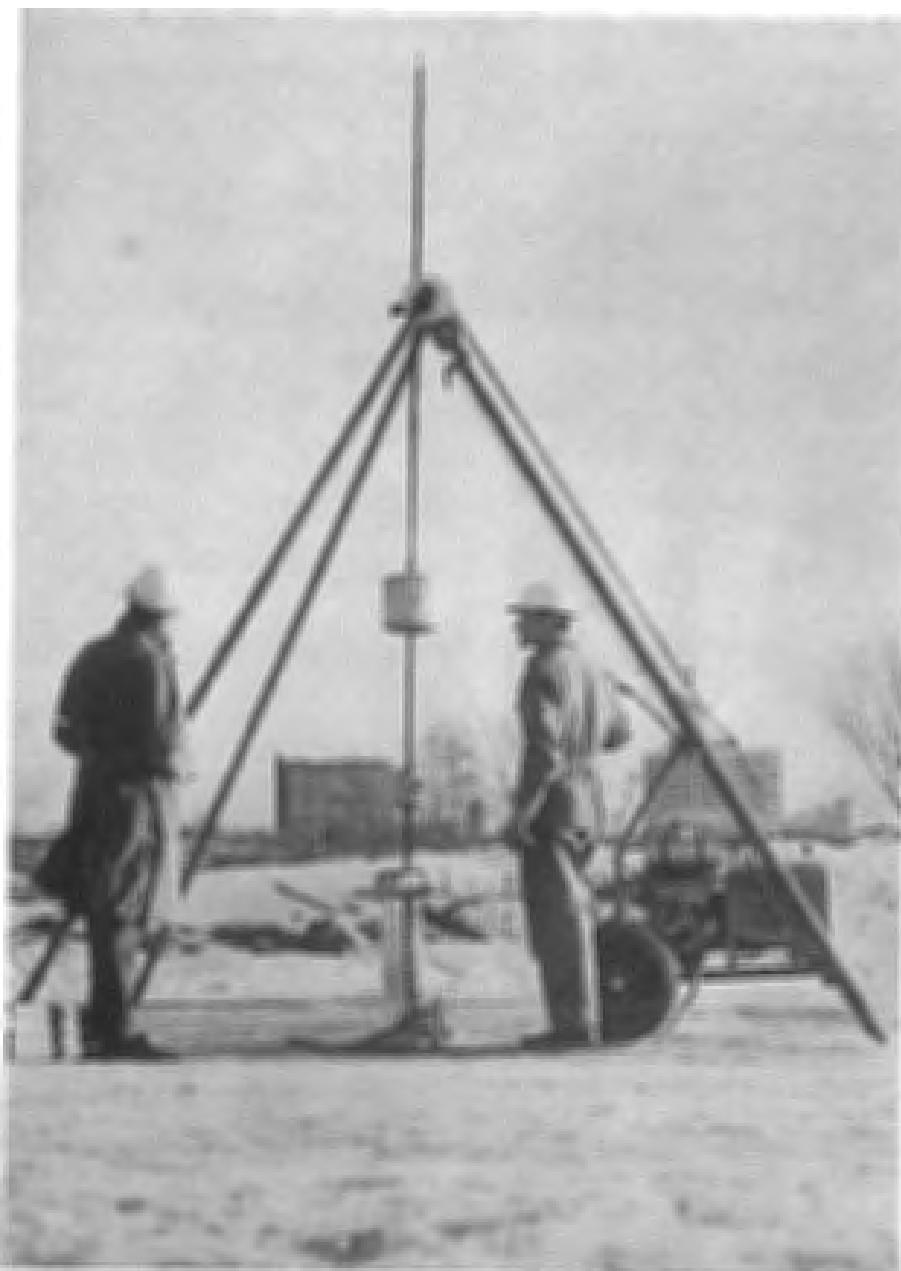
Fig. 4. Hejarborrutrustning enligt Borros AB (ES I:1)
