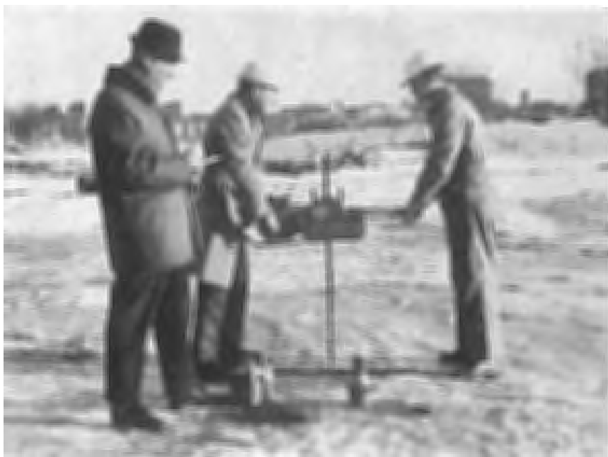
Fig. 1b. Mekaniserad viktsondering (ES I:1)
