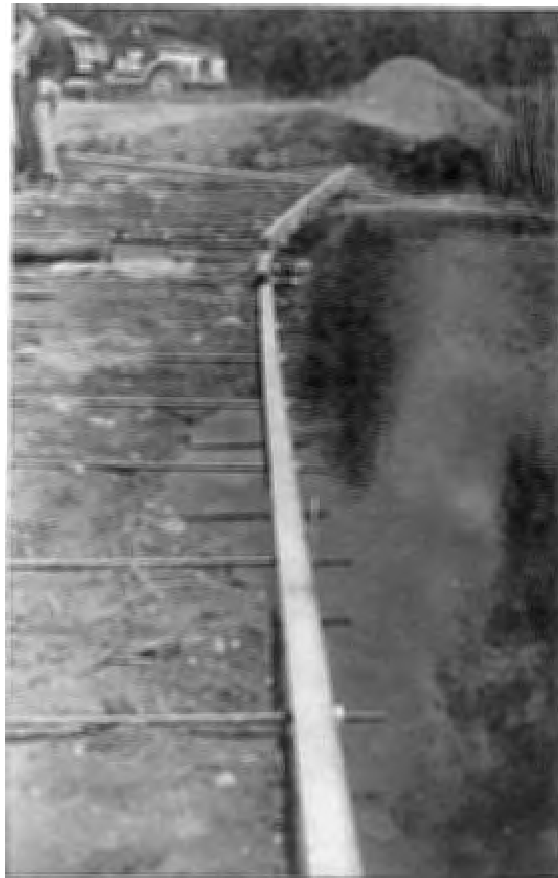
Fig 1. Spontförstärkning i slänt på väg 561 — en horisontellt lagd U-balk
