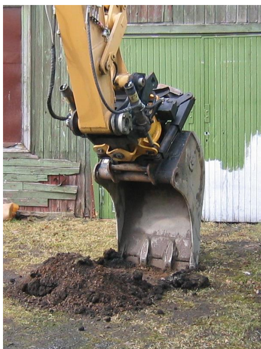
Figur 3-3. De två provtagningsstekniker som jämförs i Exempel 4: skruvborr respektive provgrop. Foto: SGI
