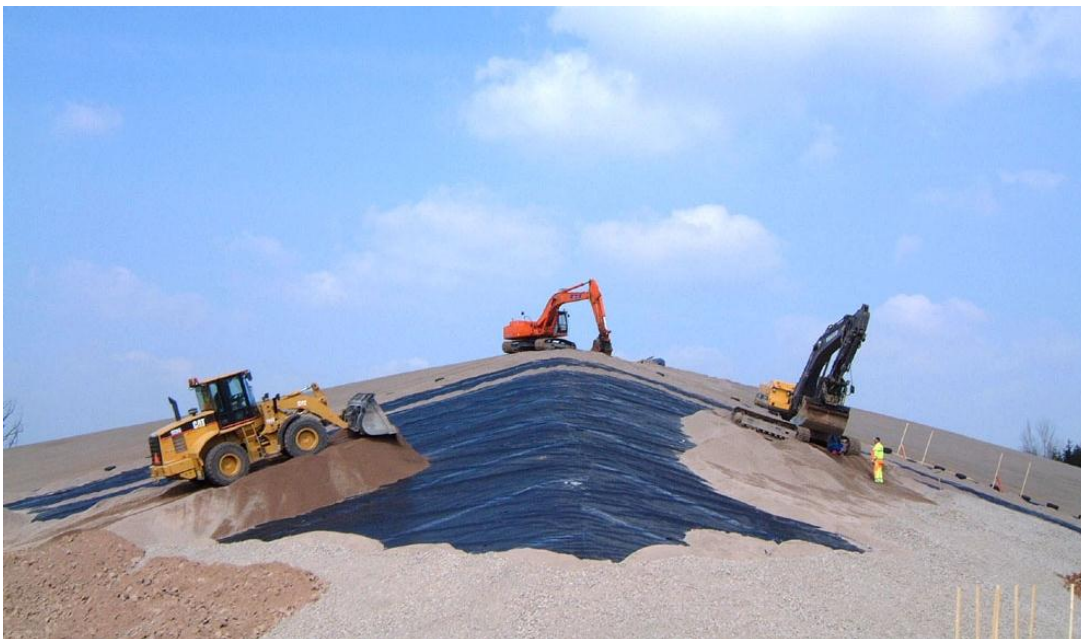
Figur 5-1 Sluttäckning av deponi. Foto: SGI.
