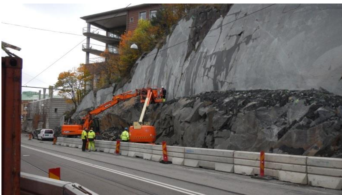
Figur 3 Exempel på byggteknik. Bilden ovan visar en bergslänt längs Aschebergsgatan i Göteborg där slänten är sprängd och helt inklädd med nät. Under 2014 har vägen breddats och man har valt att såga bergslänten vilket den nedre bilden visar. (Bilden överst är en skärmdump från Google Maps™. Bilden nederst är tagen av Magnus Eriksson.)
