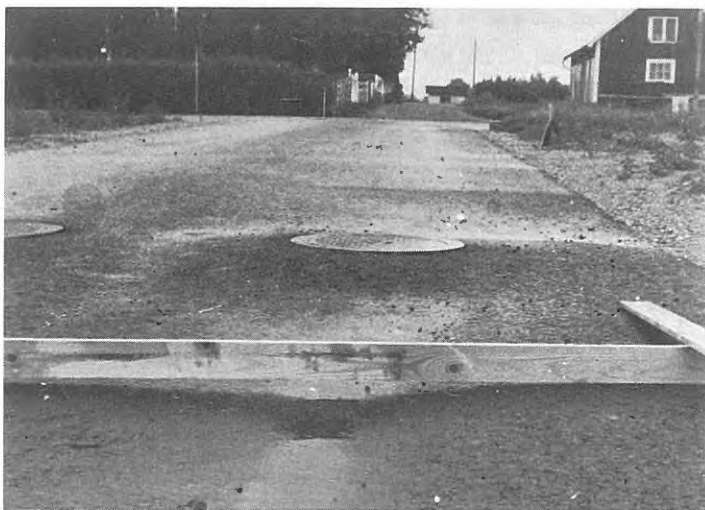
Figur 8. Exempel på sättning över ledningsgrav vid Sjögestad.
