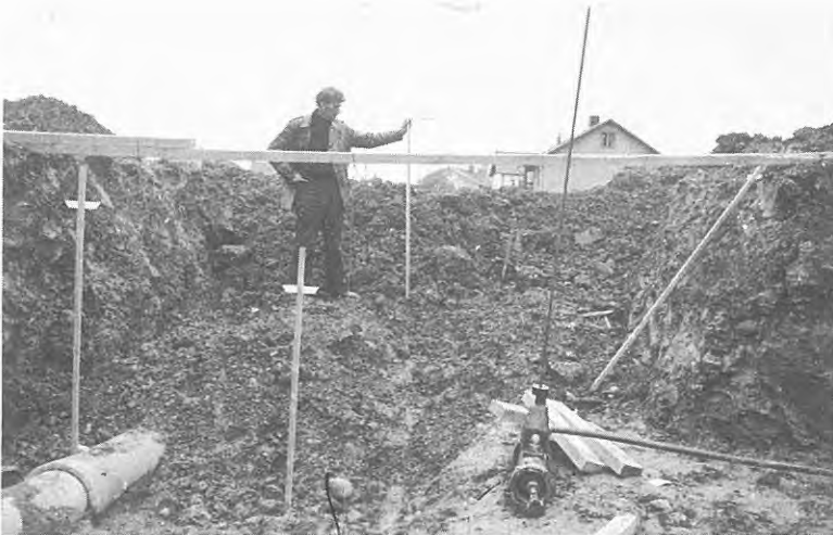
Figur 23. Återfyllning vid Sjögestad.
