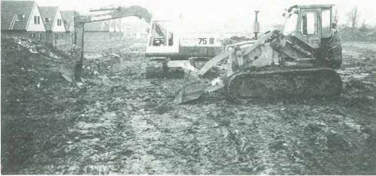
Figur 31. Packning av resterande fyllning med bandmaskin Cat 951 på terrassnivå vid Ekholmen.
