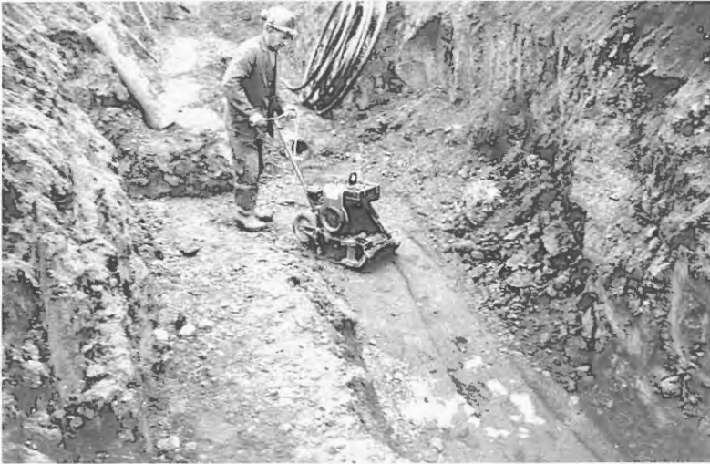
Figur 26 Packning av ledningsbädd med 100 kg vibroplatta vid Ekholmen.
