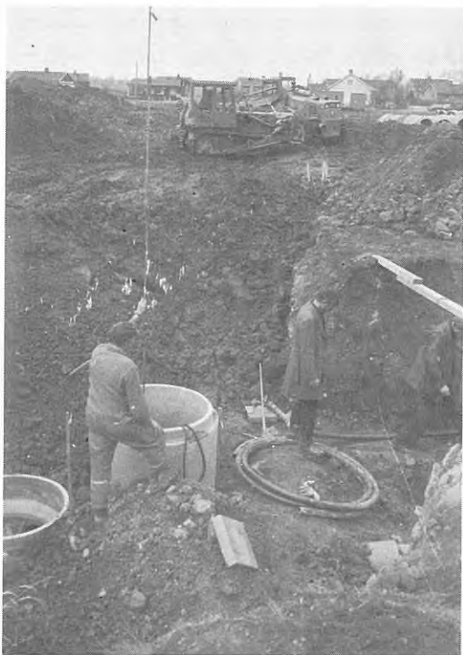
Figur 7 Packning av resterande fyllning vid Sjögestad.
