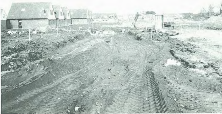
Figur 32. Utfyllning med överbyggnadsmaterial vid Ekholmen.
