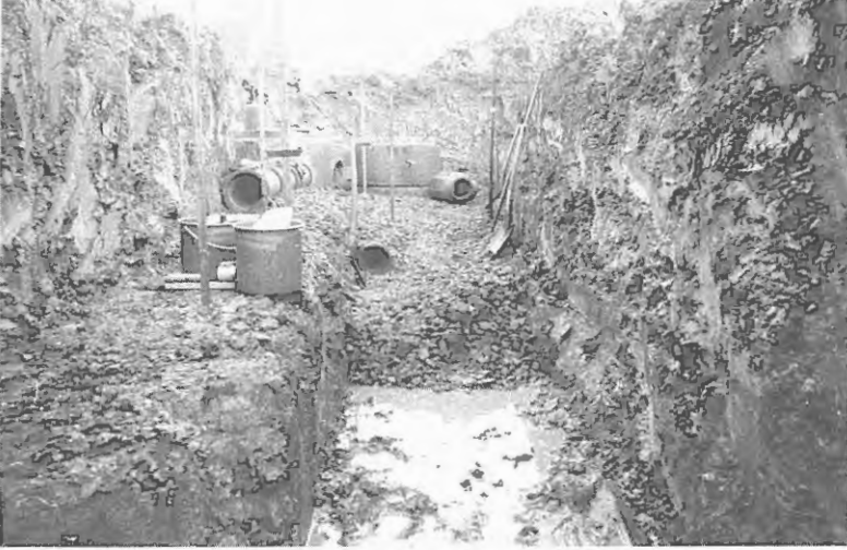
Figur 25. Ledningsgrav med hylla för dagvattenledning vid Ekholmen.
