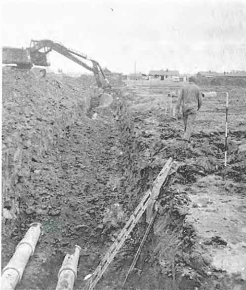
Figur 6. Packning av kringfyllning vid Sjögestad.
