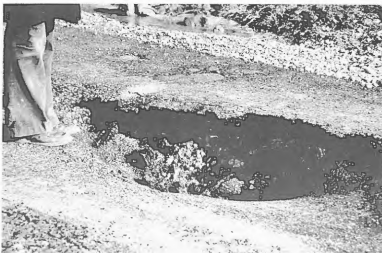
Figur 13. Lokalt genombrott i överbyggnaden vid Sturefors.
