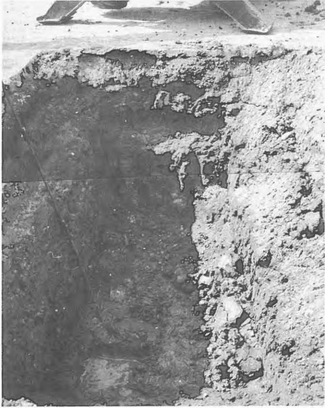
Figur 20. Vattenansamling i schaktgrop vid Sjöggestad. Schaktväggen rakt fram består under överbyggnaden av naturligt lagrad jord.
