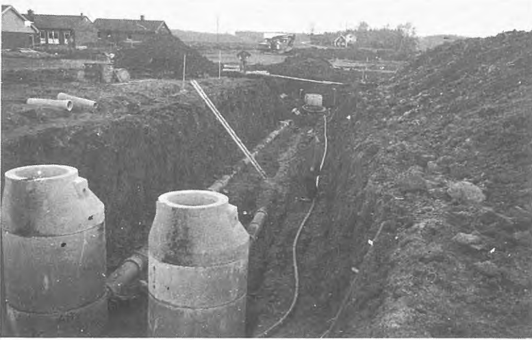
Figur 5. Ledningsschakt vid Sjögestad.
