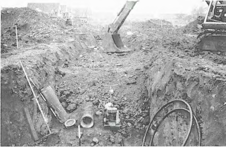
Figur 27. Packning av resterande fyllning med hjälp av grävmaskinens skopa vid Ekholmen.
