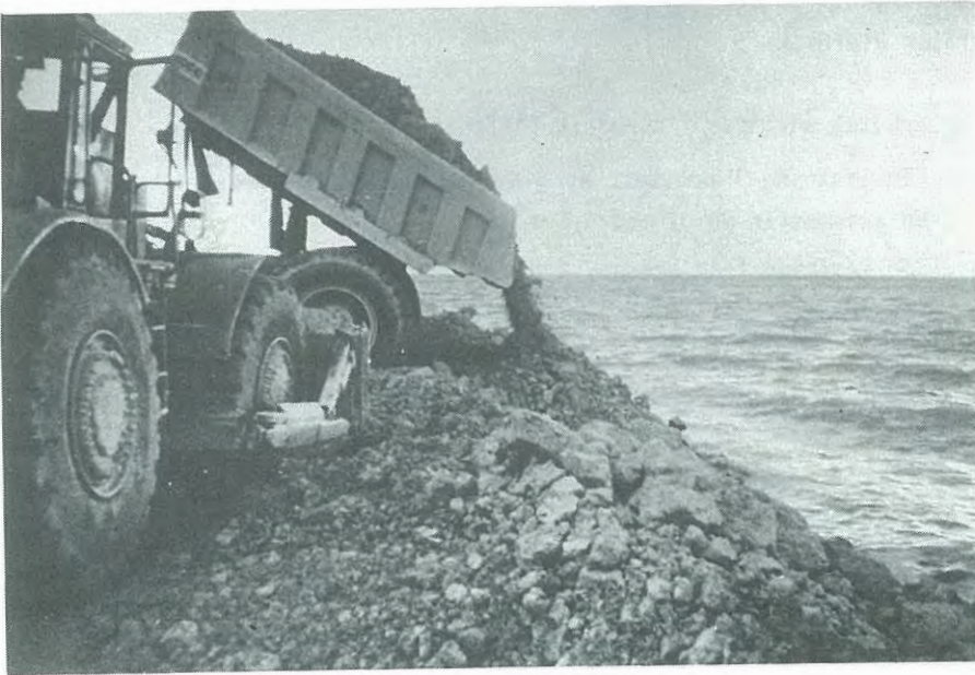
Fig. 21. Utfyllning av vattenområde genom ändtipping.
