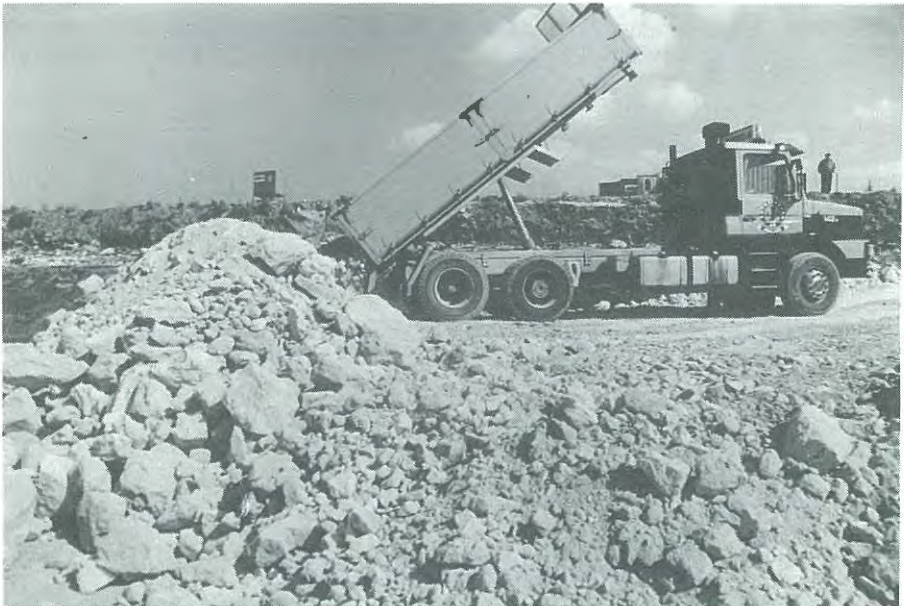
Fig. 7. Uppbyggnad av provfyllningen på SwedeChromes byggnadsområde. Structure of test fill at SwedeChrome's building site.
