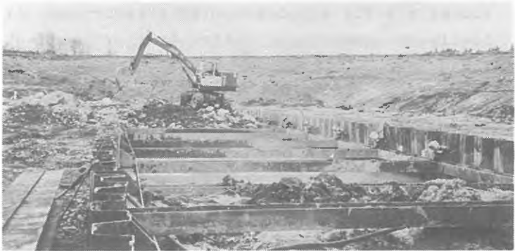
Bank av sprängsten utlagd mellan förankrad spont.
