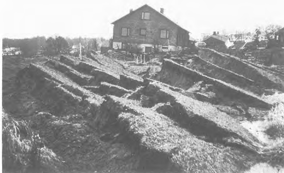
Fig. 1.6. Bilderna visar en glidyta från övre delen av skredet som följer fastmarkskonturen (övre bilden) samt den uppskjutna markytan i den passiva zonen (nedre bilden).
