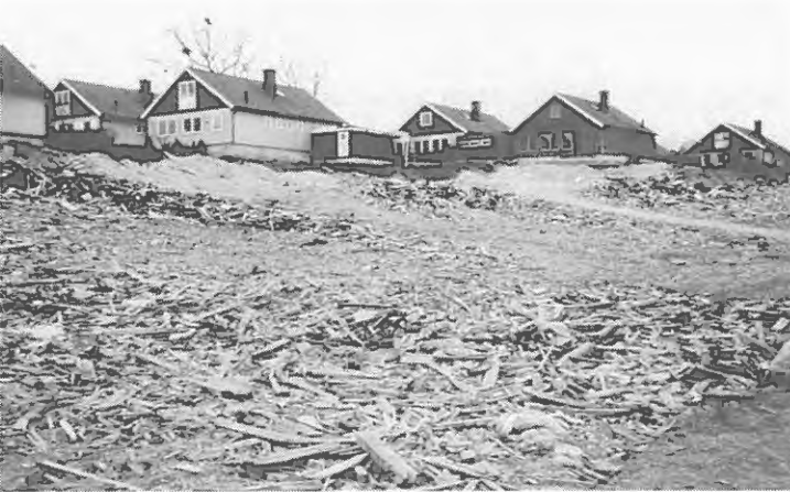
Lättfyllning utlagd för att förbättra stabiliteten.
