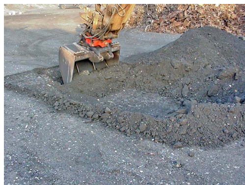
Figur 4: Schakt i slaggrus.
