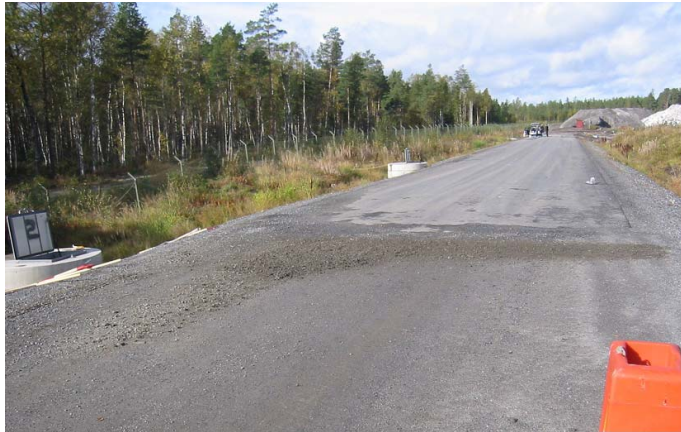
Dåvamyran, Umeå, byggd 2001.
