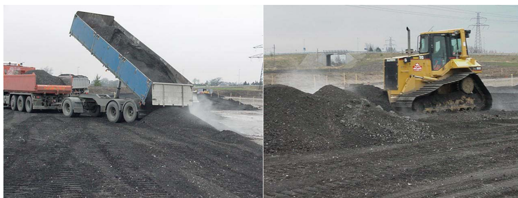
Figur 8: Utläggning av slaggrus.
