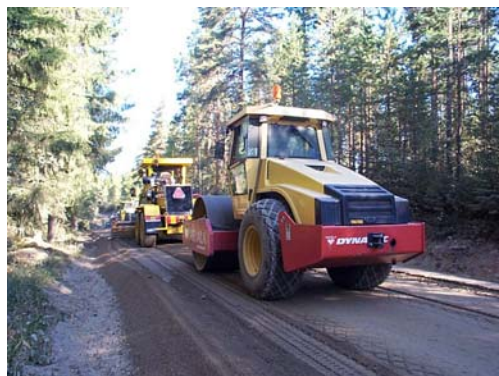
Figur 6: Packning av slitlager.
