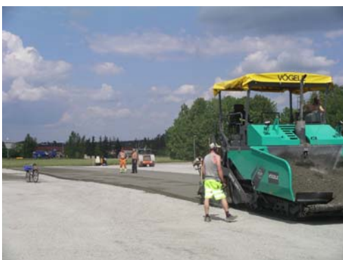
Figur 10a: Läggnig av markbetong.
