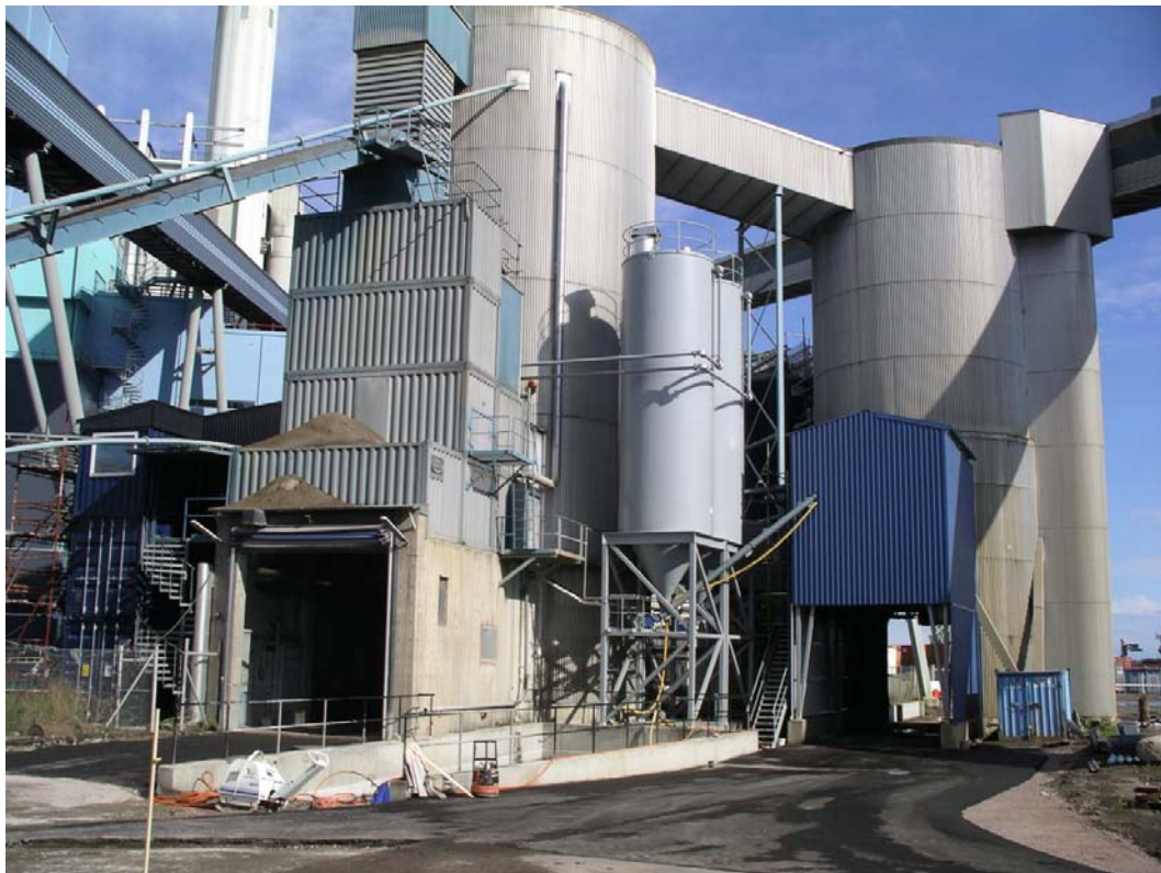
Figur 1: Anläggningar för blandning av aska hos Mälarenergi AB i Västerås.
