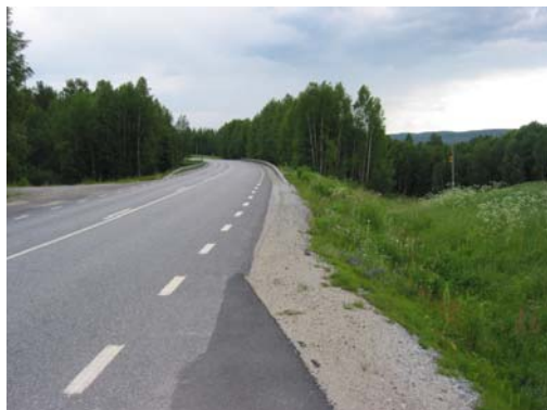
Figur 3: Bärighetshöjande åtgärder, belagda vägar och industriytor.
