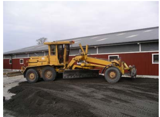
Figur 7b: Packning med hyvel.
