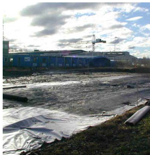
Figur 4: Utläggning av geotextil och geonät på terrass.
