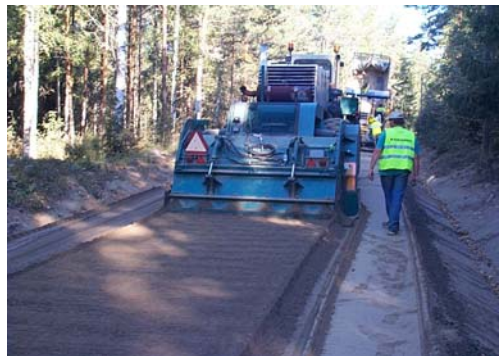
Figur 4: Infräsning till 0,2m djup i befintlig väg.
