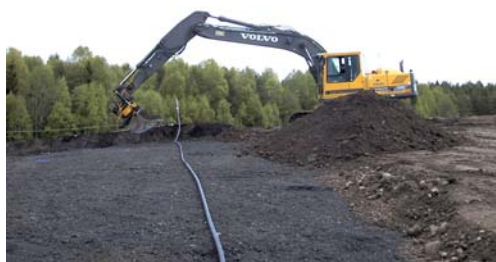
Figur 6: Tät- och avjämnings-skikt för deponier.
