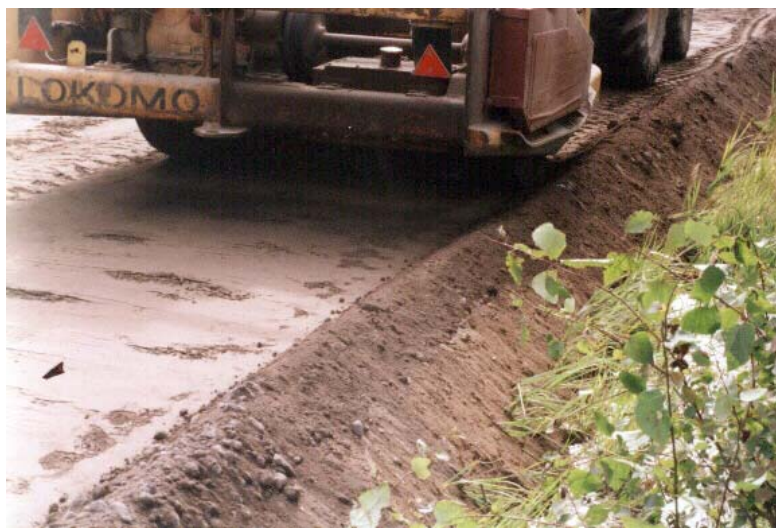
Figur 4: Sidostöd hjälper till att packa jämnt hela vägen.
