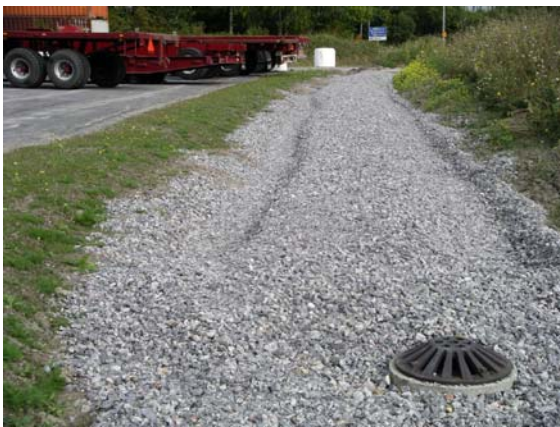
Figur 9a: Dränerings grusdike.
