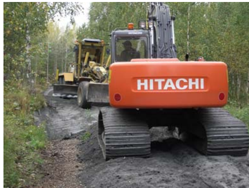
Figur 5a: Utläggning av flygaska.
