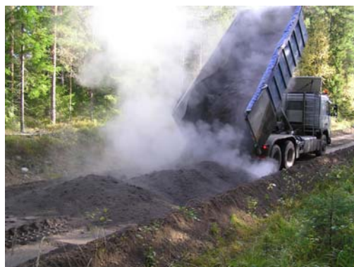
Figur 2a: Utläggning av flygaska.
