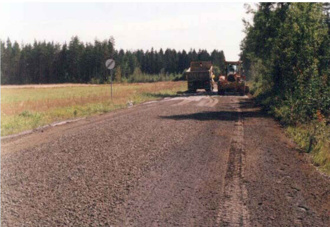
Figur 5: Täckning med krossmaterial.
