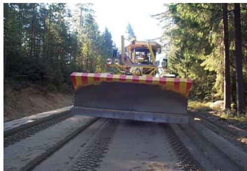
Figur 5: Avjämnning med väghyvel.
