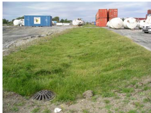
Figur 9b: Dagvattenfördröjande gräsdike.
