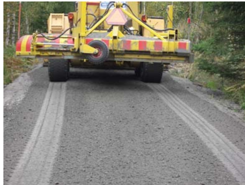
Figur 5b: Färdig blandning av flygaska och grus.
