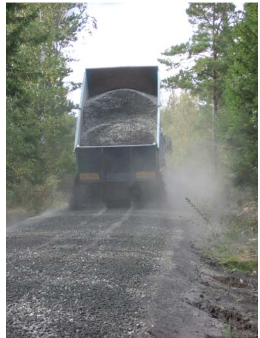
Figur 8: Slitlager av grus påförs.
