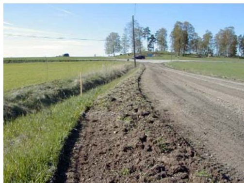
Figur 14 & 15: Indragning av kanter, central åtgärd vid förbättrings- och underhållsarbete av grusvägar, för att förbättra avvattningen.
