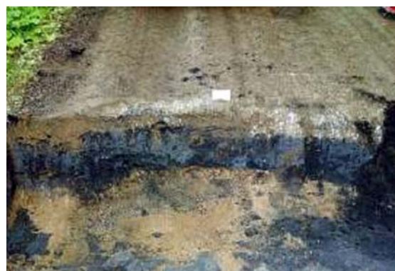
Figur 7: Tv enbart flygaska i ett lager och th flygaska blandat med grus som bär- och förstärkningslager.
