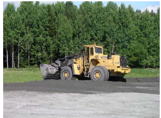
Figur 7a: Packning med lastmaskin.
