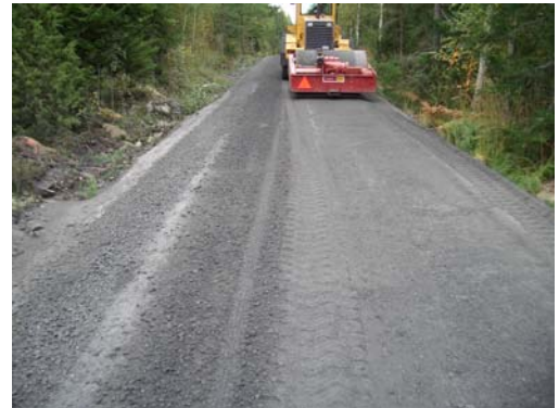
Figur 7: Packning med vibrovält.
