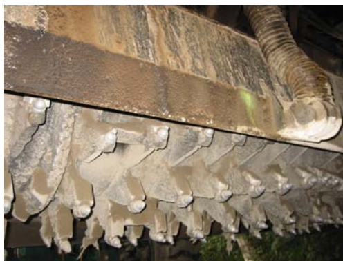
Figur 16: Blandning av flygaska med befintligt vägmateriell genom infräsning.
