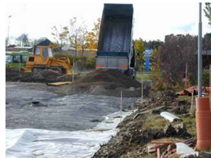
Figur 6: Tippning av askan.
