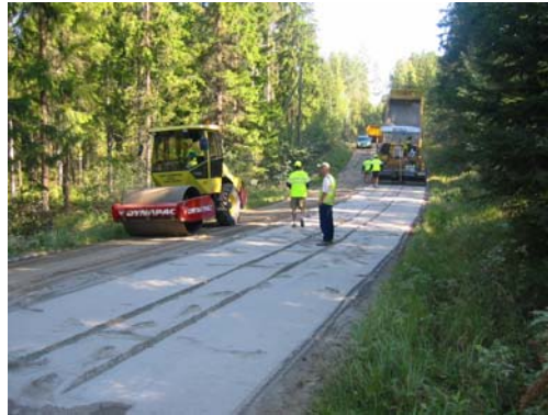
Figur 3: Flygaska före infräsning i befintlig väg.
