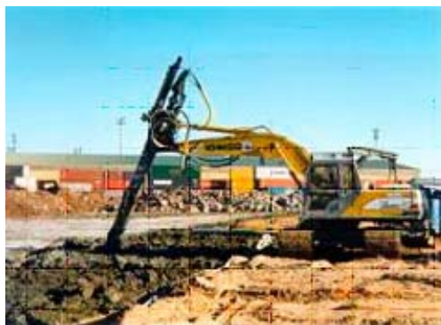
Figur 5: Stabilisering av lösa jordar, terrass & muddermassor, markexploatering.
