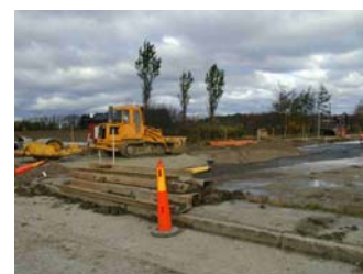
Figur 8: Packning av askan.
