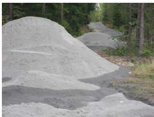
Figur 4: Flygaskan utlagd i högar med ca 20 – 30 m mellanrum.
