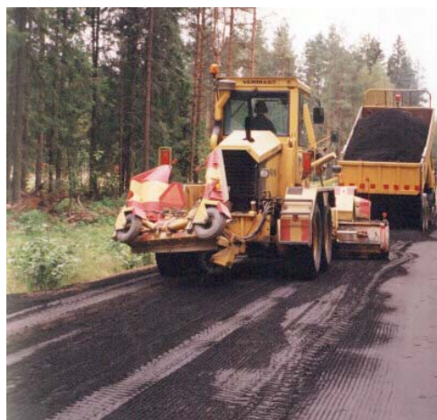
Figur 3: Trafikering är möjligt under vägbyggandet.
