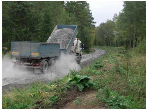
Figur 6: Utläggning av flygaska.
