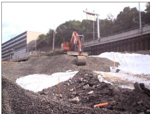
Figur C2-2b. Planering och packning av skumglas med grävmaskin.
