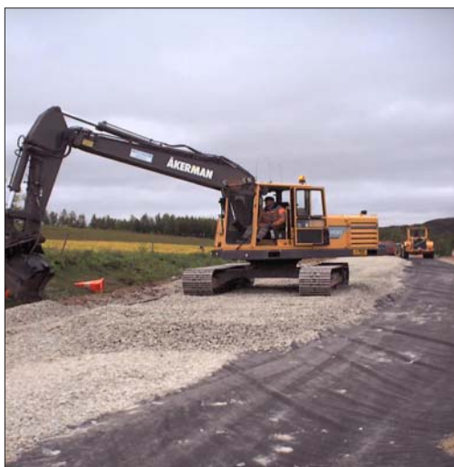
Figur C4-2b. Planering och packning av skumglas.
