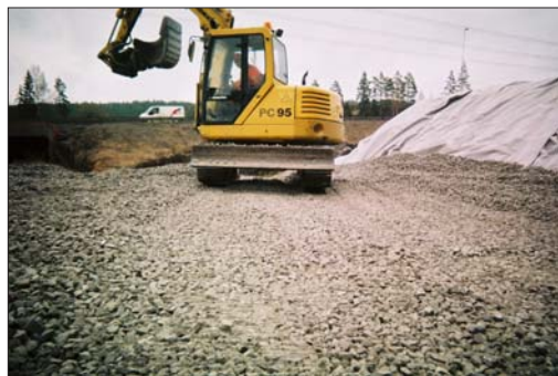
Figur C1-2c. Packning av skumglaset med bandtryck 45 kN/m 2 .
