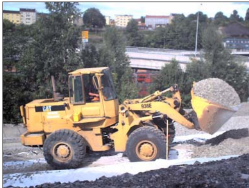
Figur C2-2a. Internt transport av skumglas (©HASOPOR lätt).
