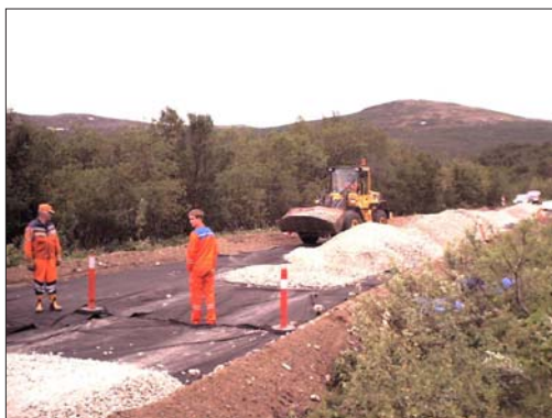
Figur C4-2a. Intern transport av Skumglas (©HASO-POR std).
