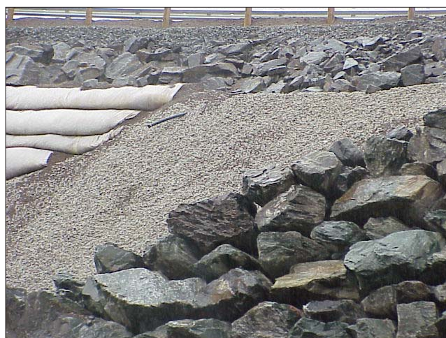
Figur 3.2. Provisorisk vägsträcka med släntlutning 1:1,25 där skumglas och lättklinker använts som lätt fyllning. Observera att lättklinkern har armerats med omlottladga geotextiler för att klara den branta slänten medan skumglasslätten ligger utan åtgärder.
