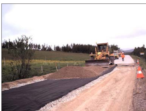
Figur C4-2d. Planering av bärlagret med väghyvel.
