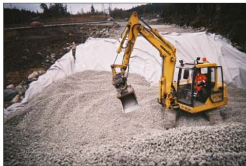
Figur C1-2b. Planering och packning av skumglaset med grävmaskin.
