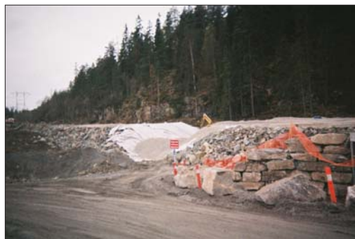
Figur C1-2a. Geotextil under och på sidan av blivande skumglasfyllning.
