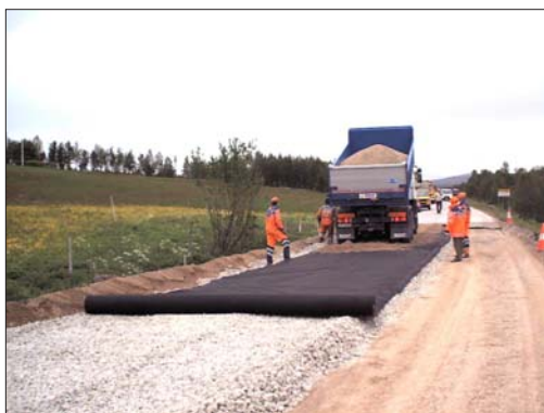
Figur C4-2c. Inkörning av bärlagret.
