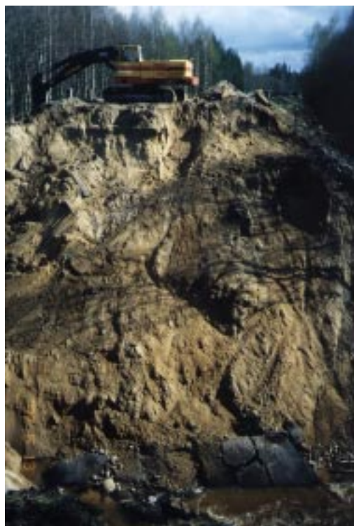
Fig. 1.12 Vägbank av silt som brutits igenom och delvis spolats bort på våren på grund av en delvis igensatt och förklent dimensionerad dräneringstrumma Foto Björn Hedberg.
