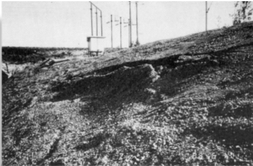
Fig. 1.5 Släntskred i samband med tjällossning. Erosionsskyddet påfördes i detta fall på en tjälad och delvis snötäckt slänt, (7).
