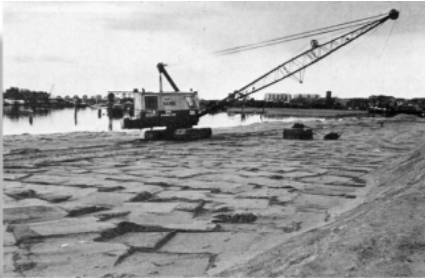
Fig. 1.15 Fallviktspackning av siltjord, (25). Mönstret på fyllnings överyta visar var fallvikten släppts.
