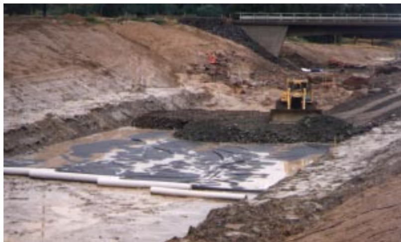
Fig. 1.13 Utläggning av geotextil och makadamlager på vattenmätad silt vid vägbygge i en skärning. Foto Björn Hedberg.
