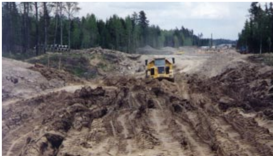
Fig. 1.3 Spårbildning från arbetsmaskiner i silt med stort vatteninnehåll. Foto Björn Hedberg.
