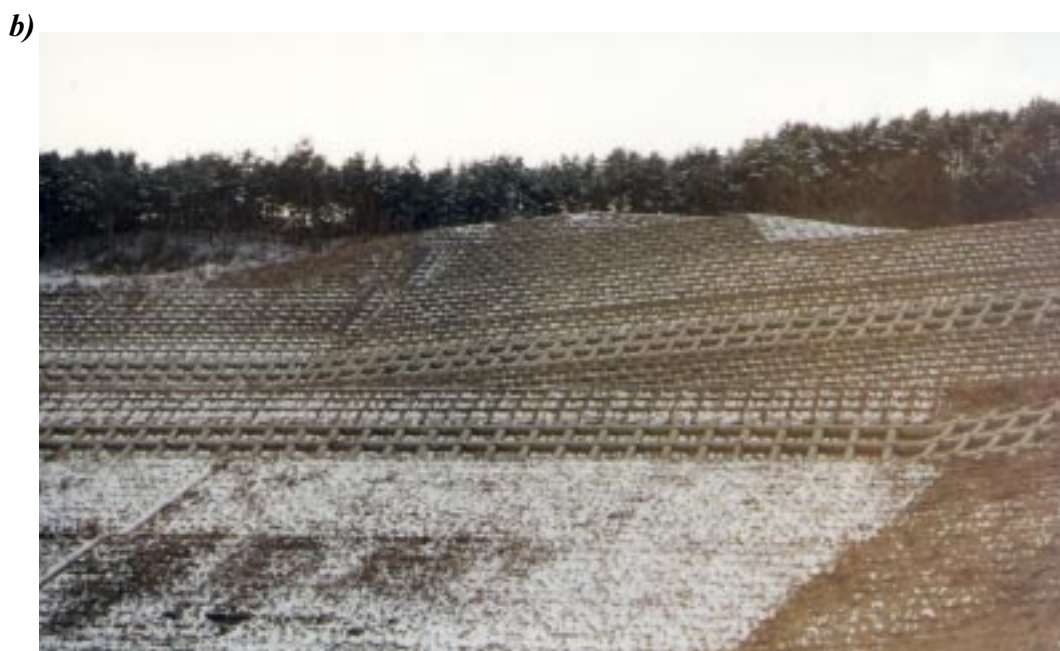
Fig. 1.16 a) Princip för jordspikning av en slänt b) Exempel på jordspikning med spikskallarna ingjutna i ett stabiliserande rutnät av betongbalkar. I släntens undre del har ny vegetation redan etablerats inom rutsystemet och betongen delvis dolts. Honshu, Japan.
