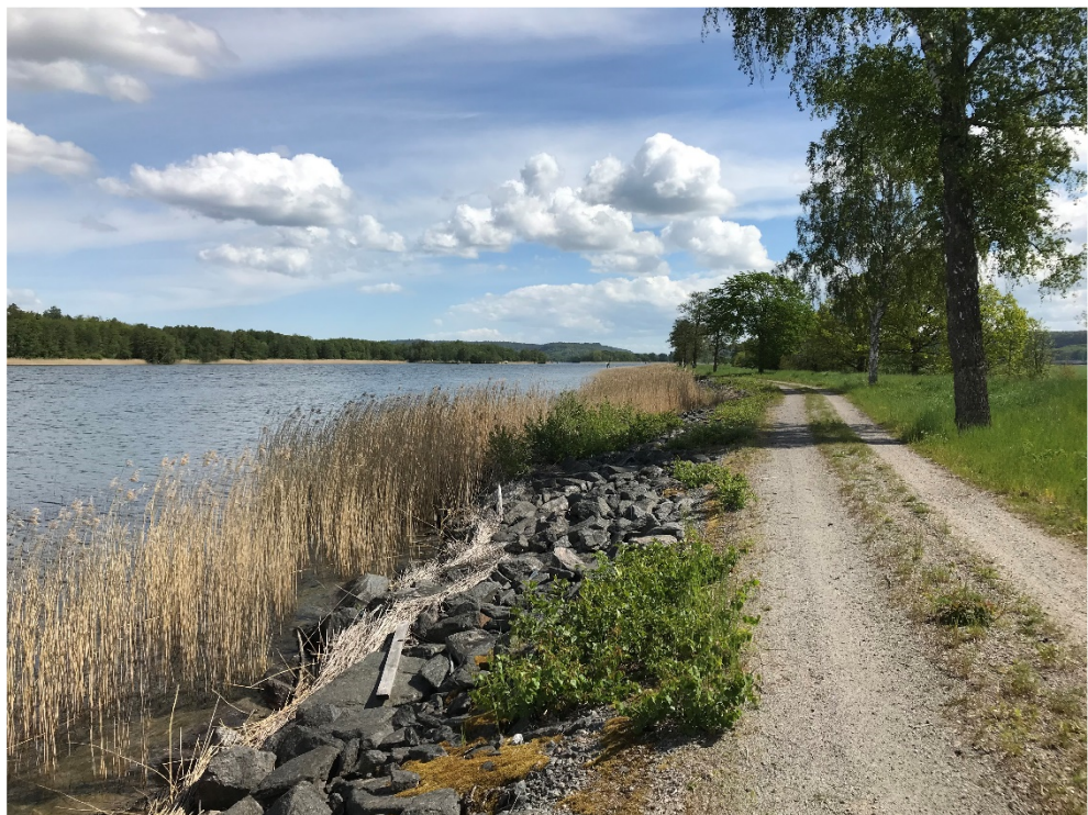
Figur 2. Dammanläggningen som utgörs av en sprängstensvall. Fotograferat från väst med Göta älv till vänster i bild (COWI AB, 2020)
