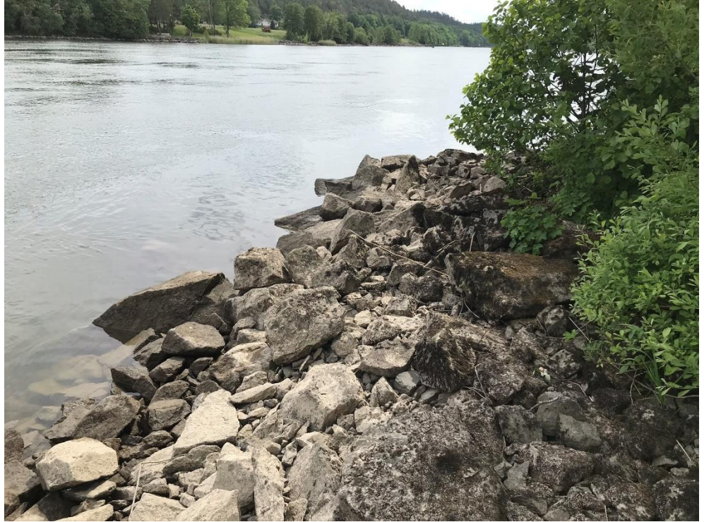
Figur 6 Erosionsskydd i norra delen av området, fotograferat mot söder (COWI AB, 2020).
