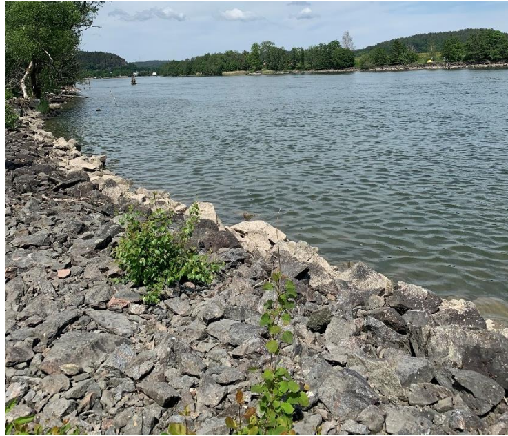
Figur 9 Erosionsskydd i södra delen av området fotograferat mot norr (COWI AB, 2020).
