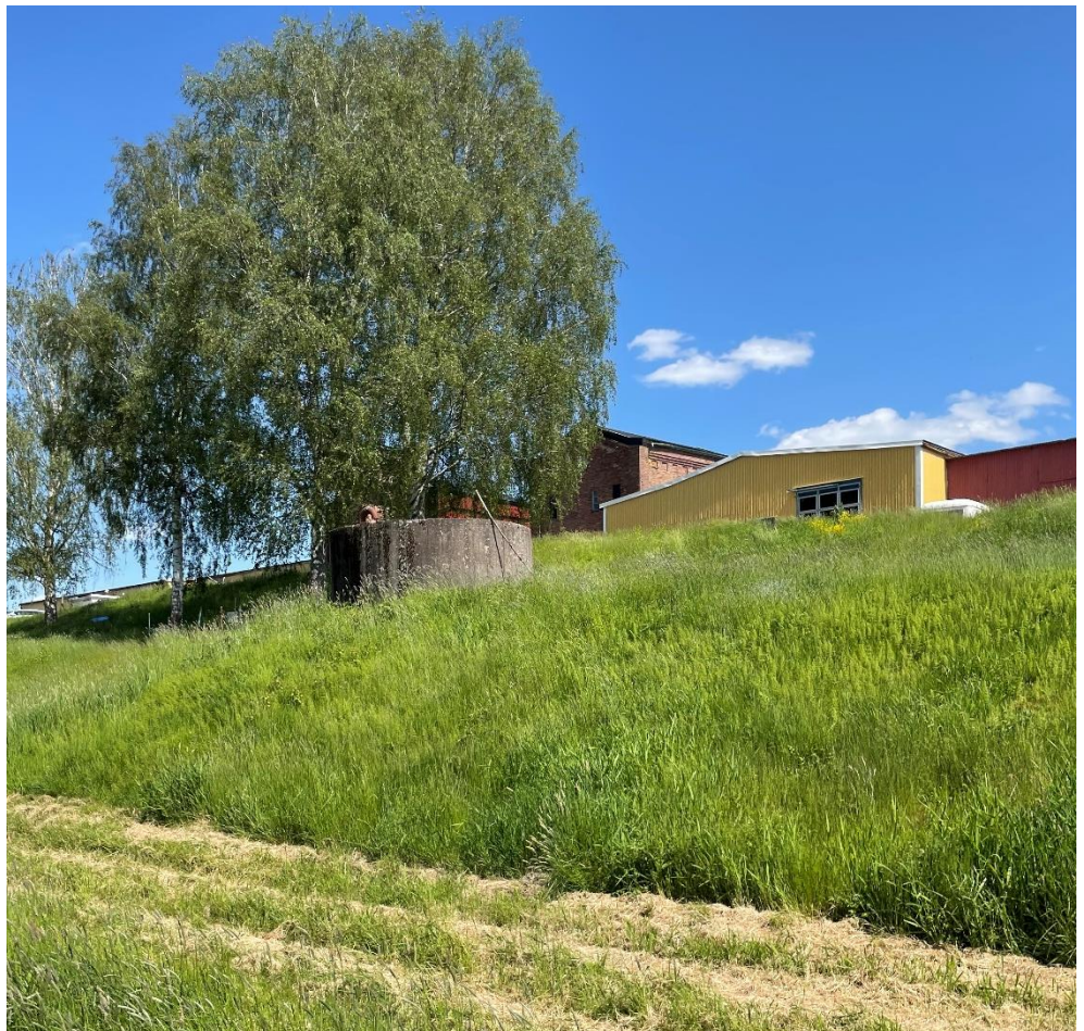
Figur 5 Cirkelformad betongkonstruktion i slänten, fotograferat från väst (COWI AB, 2021)
