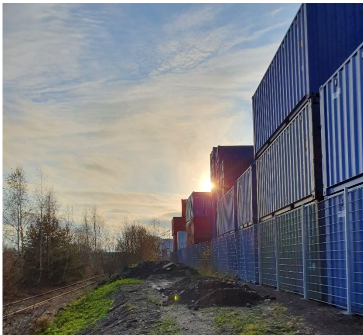
Figur 6-5 Uppställning av containrar på områdets sydvästra del. Fotoriktning mot söder. (Foto från platsbesök 2019-11-14).
