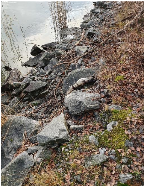
Figur 6-3 Erosionsskydd (bergkross) längs med älvstranden, foto från platsbesök 2019-11-14.
