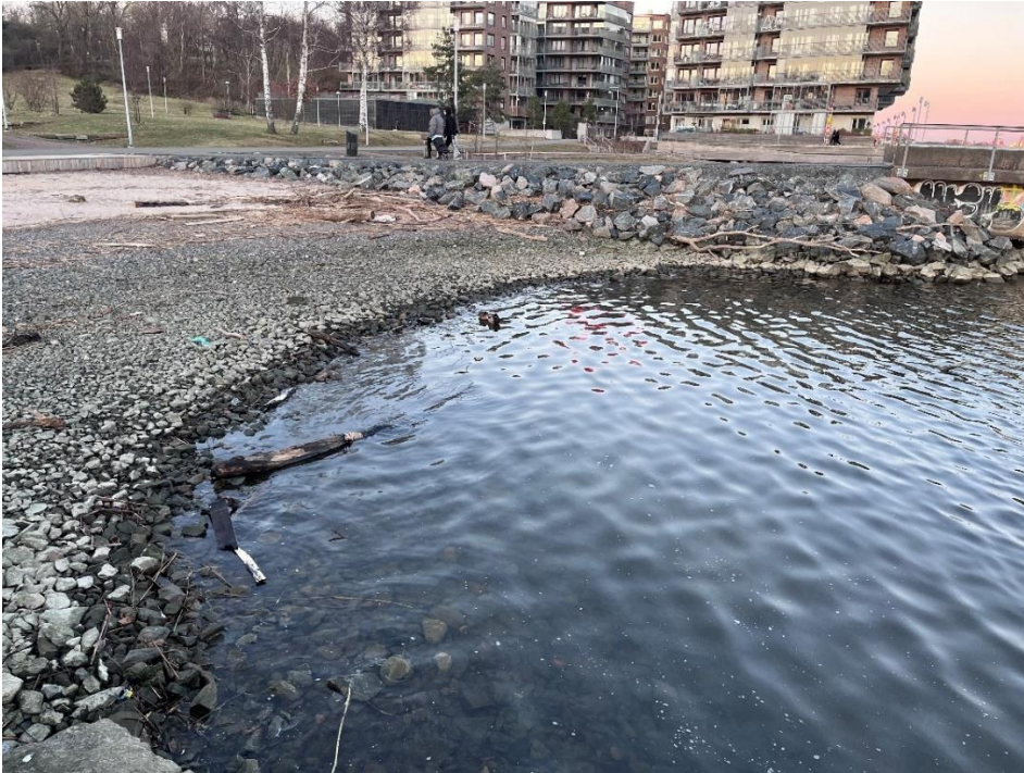
Figur 5.18: Bild på befintligt erosionsskydd vid östra stranden. Foto taget i nordostlig riktning vid platsbesök av WSP, 2025-02-11.
