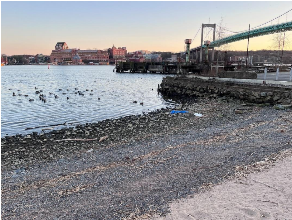
Figur 5.17: Befintligt erosionsskydd vid västra stranden. Bild tagen i sydvästlig riktning vid platsbesök av WSP, 2025-02-11.
