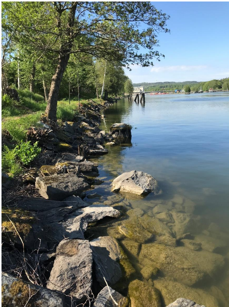
Figur 4 Utlagt erosionsskydd i strandkanten. Bilden tagen mot söder
