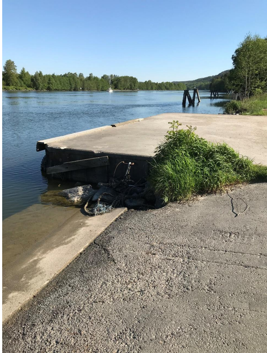
Figur 3 Iläggingsplats och betongbrygga inom områdets södra del.
