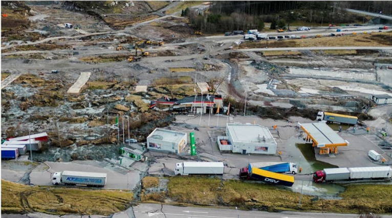
Skredet på E6 vid Stenungsund inträffade natten till 23 september i fjol. Foto: Veronika Ljung-Nielsen
