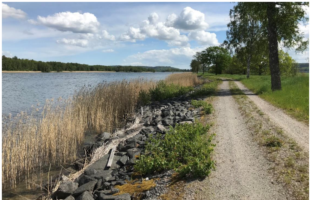
Figur 2. Dammanläggningen som utgörs av en sprängstensvall. Fotograferat från väst med Göta älv till vänster i bild (COWI AB, 2020)
