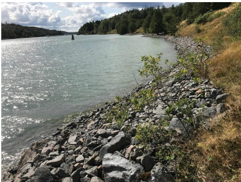
Figur 17: Foto av erosionsskydd taget mot söder km ca 16/400.
