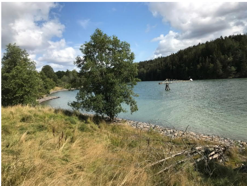
Figur 16: Foto erosionsskydd taget mot norr km ca 17/100
