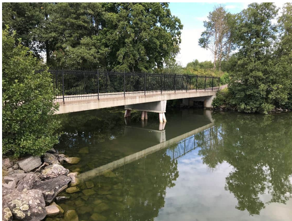
Figur 8 Betongbro över Strömsbäcken. Foto taget mot norr, daterat 2022-08-23
