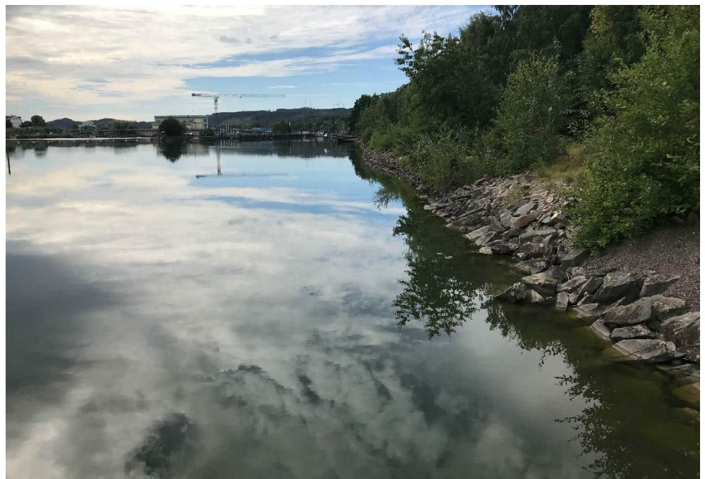
Figur 10 Utlagt erosionsskydd i strandkanten mot Göta älv. Fotot taget mot söder, daterat 2022-08-23
