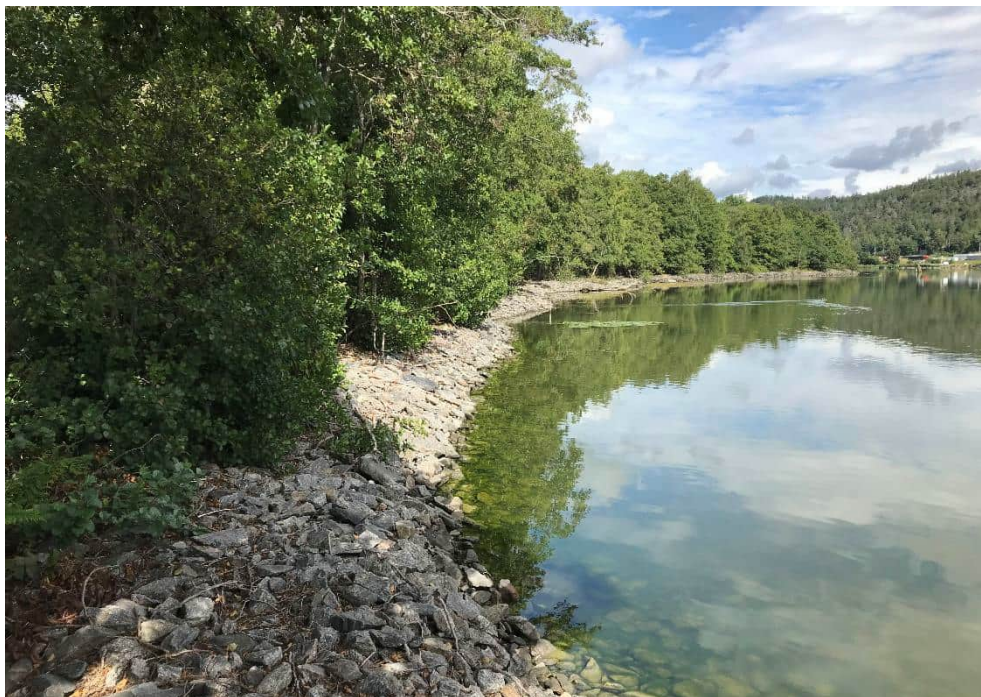
Figur 9 Utlagt erosionsskydd i strandkanten mot Göta älv. Fotot taget mot norr, daterat 2022-08-23
