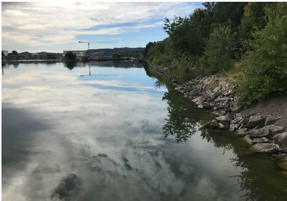
Figur 10 Utlagt erosionsskydd i strandkanten mot Göta älv. Fotot taget mot söder, daterat 2022-08-23
