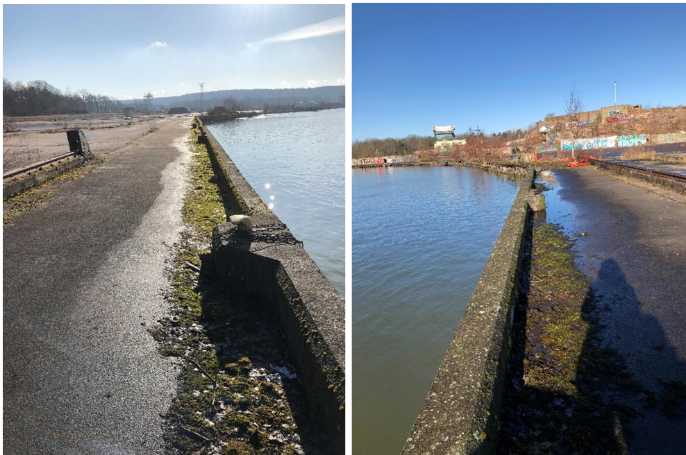
Figur 2 Betongkajen från 1980-talet. Till vänster vy mot söder och till höger vy mot norr. (Foto: Sweco)
