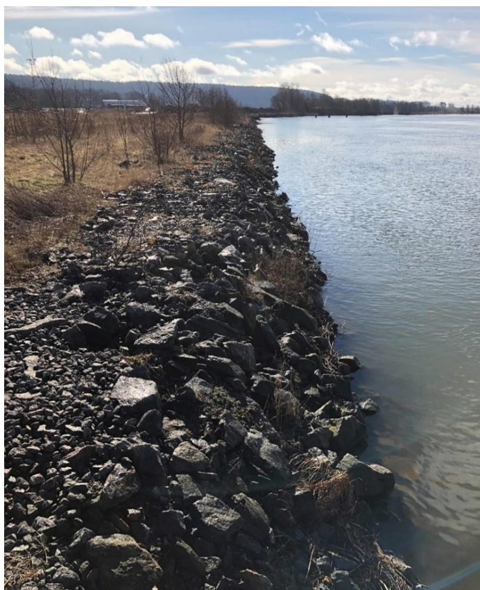
Figur 8 Erosionsskyddet vid strandlinjen längs Göta älv i det södra delområdet, vy mot söder. (Foto: Sweco).
