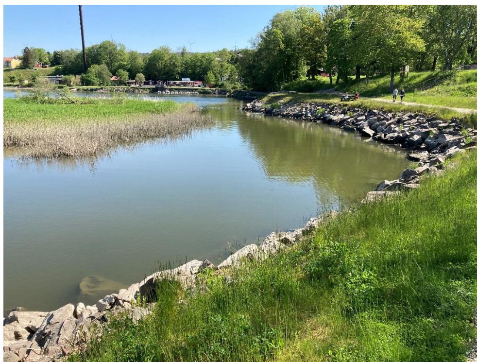
Figur 4. Erosionsskydd i norra delen av utredningsområdet, fotograferat åt nordost (COWI AB, 2021).
