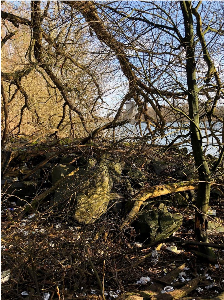
Figur 2 Område 1, synliga block vid släntrön. Fotoriktning åt norr.
