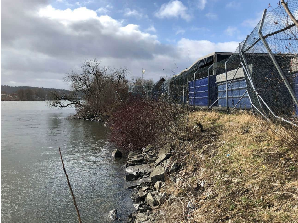
Figur 7 Område 4, sprängsten/krossmaterial vid strandkanten och endast ett smalt område mellan staketet och erosionsskyddet. Fotoriktning åt söder.
