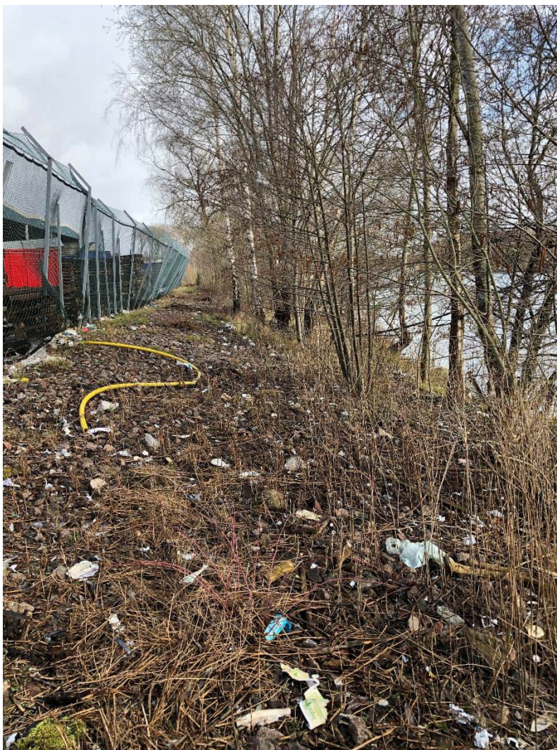
Figur 5-4 Området närmast utanför staketet är belagt med krossmaterial innan växtlighet tar vid i området närmast älven och erosionsskyddet. Foto taget vid besiktning av erosionsskydd. Fotoposition i södra delen av verksamhetsområdet, fotoriktning åt norr.
