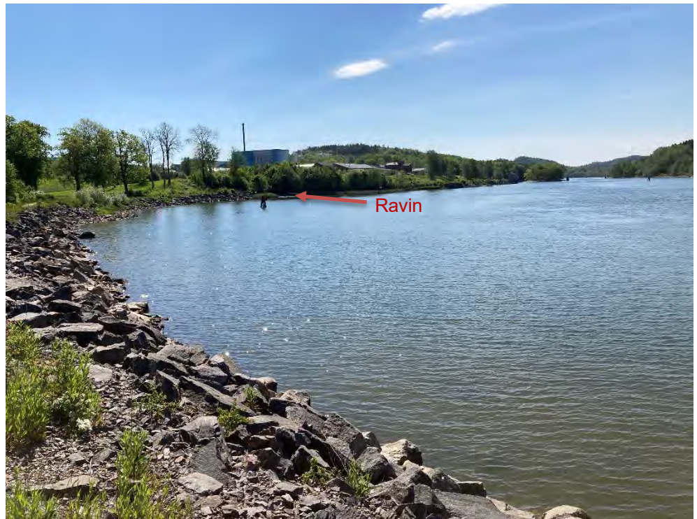
Figur 6. Erosionsskydd utmed Göta älv i utredningsområdets norra del, fotograferat åt sydost (COWI AB, 2021).
