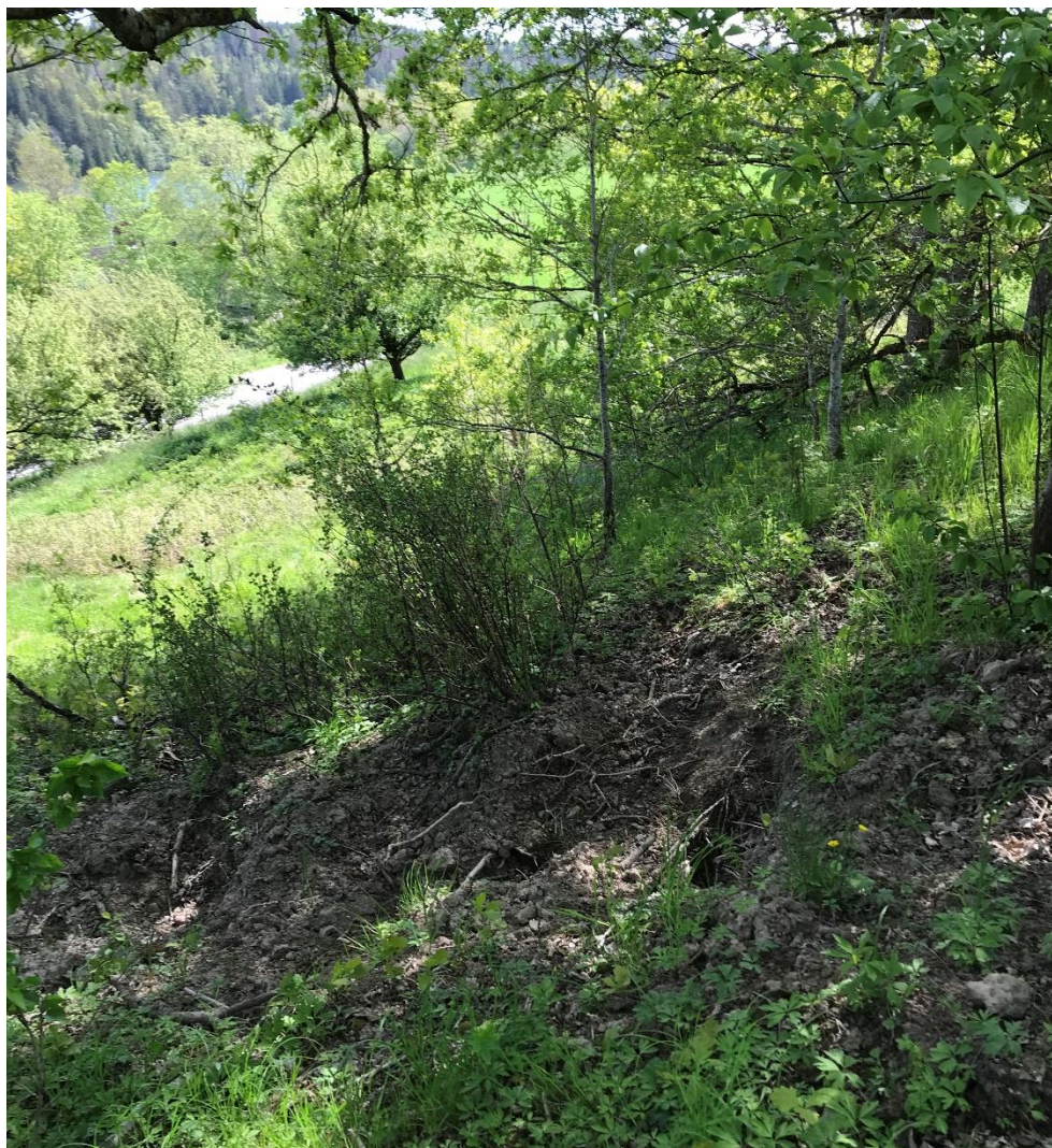
Figur 5. Sprickor i markytan inom delområde E. Längst upp till vänster i bilden skymtas Göta älv och Edsvägen. (COWI AB, 2020)
