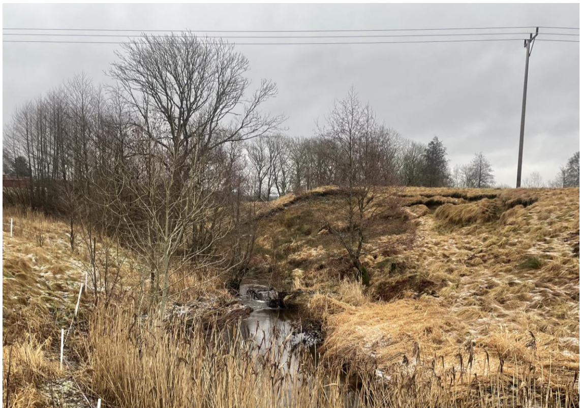
Figur 2. Skredärr som observerats i områdets nordvästra del.
