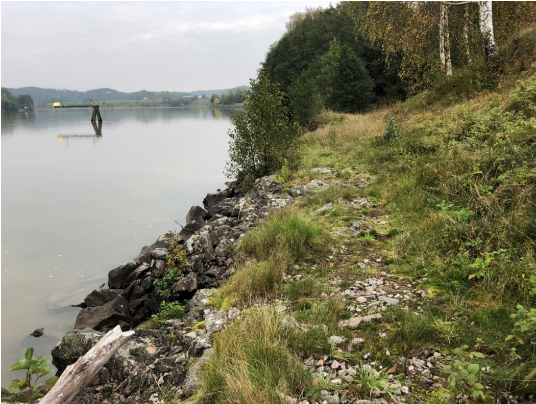
Figur 3: Erosionsskydd i form av sprängstensbank längs Göta älv.
