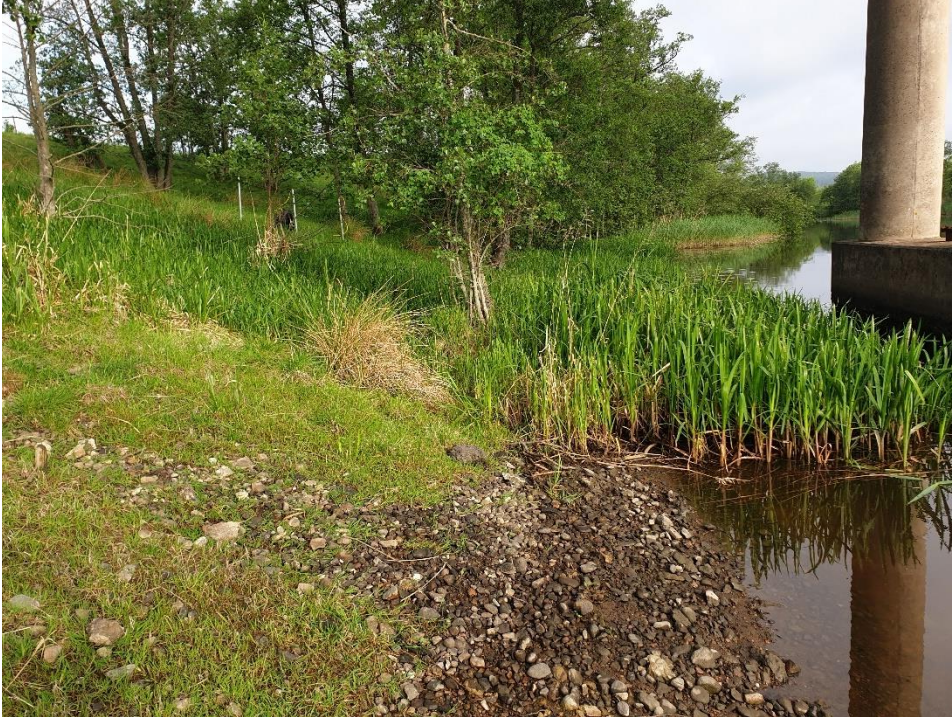
Figur 5: Erosionsskydd i anslutning till bron där väg E45 korsar Slumpån.
