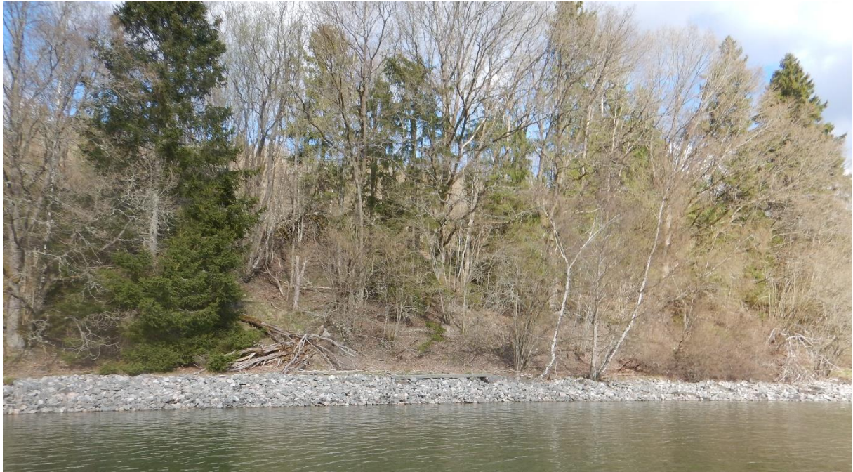
Figur 3-3: Sprängstensvall längs Göta älvs strandlinje. Foto taget 2023-04-27, i samband med SGI:s besiktningsresa med båt.
