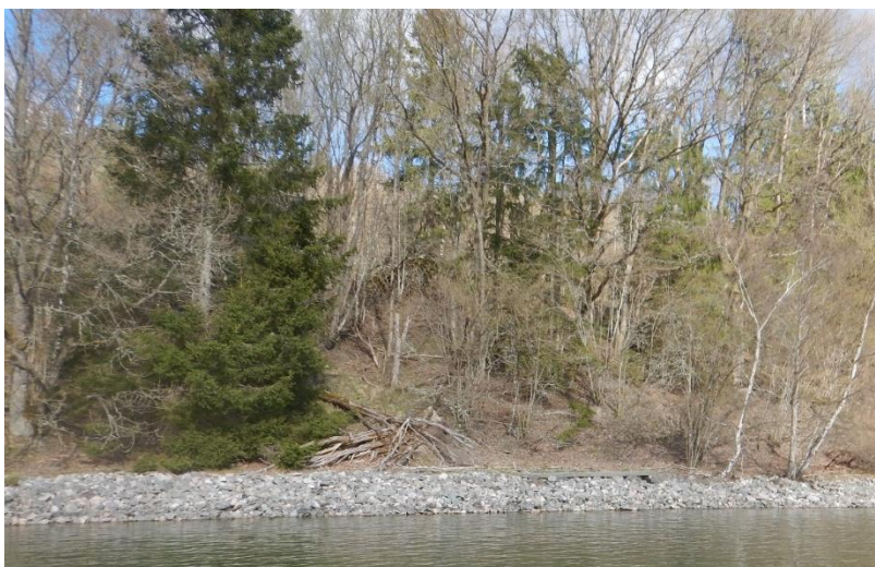
Figur 5-11: Erosionsskydd längs Göta älv, norr om den norra sidoravinen, utlagt av Sjöfartsverket 2018 (Foto, SGI, 2023-04-27)
